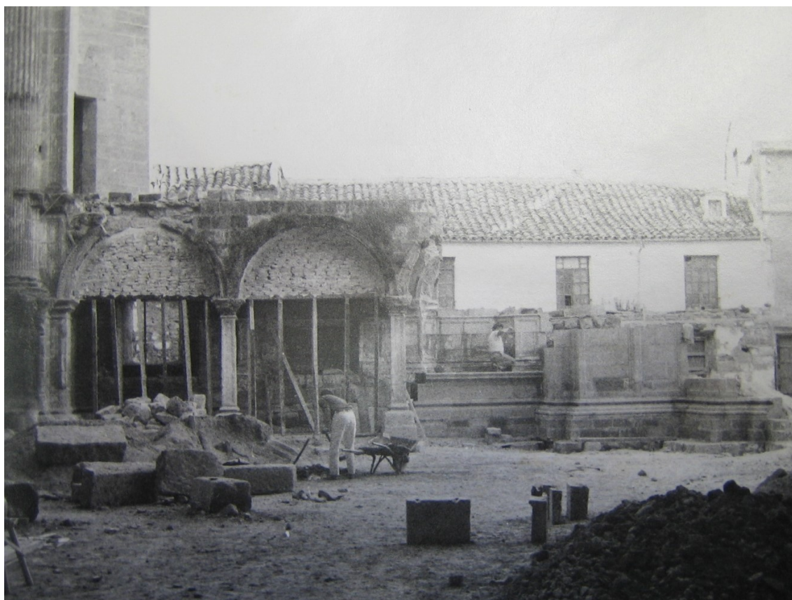
Ilustración 7. Obras de restauración de los arcos de la Capilla Mayor. El tercer arco aún no se ha completado. Autor: José Antonio Llopis. Con permiso para su publicación en erph.
