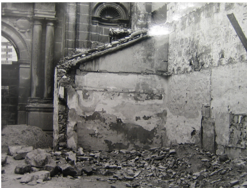
Ilustración 3. Estado de la fachada de la iglesia de San Francisco antes de las intervenciones de Prieto-Moreno y Llopis. Se pueden ver parte de las construcciones que se adosaban a la misma. Autor: José Antonio Llopis. Con permiso para su publicación en erph.
