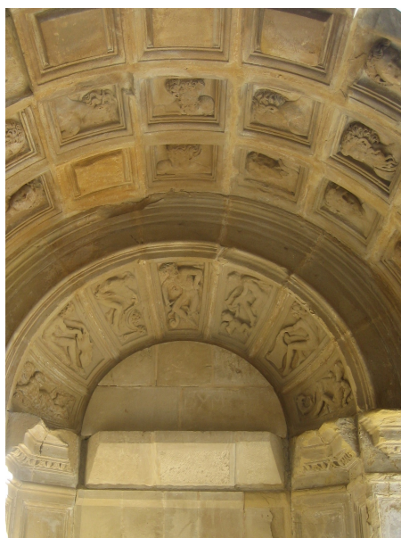
Ilustración 9. Araujo y Nadal. Restitución de moldura. Se observa asimismo parte del arco restaurado por Llopis. Elaboración propia.
