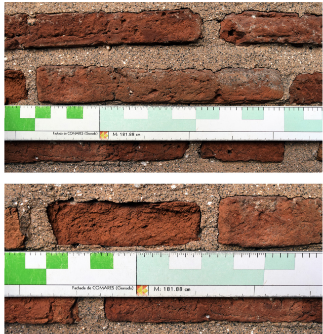
Figura 12. Formato tipo de las fábricas de ladrillo.
