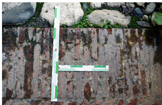
Figura 9. Encintado entre pilastras.
