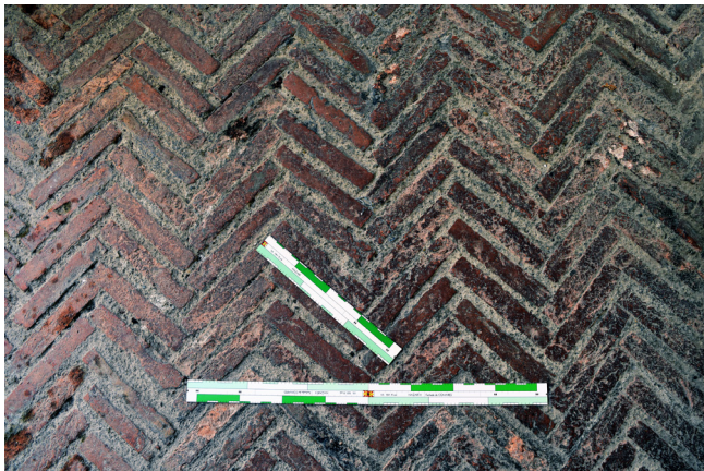
Figura 10. Solería en espiga.
