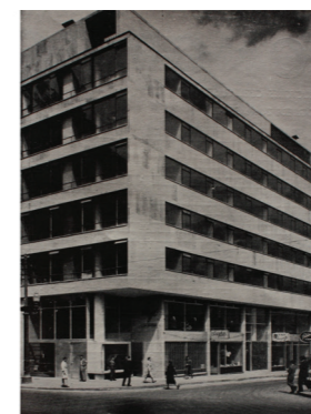
EDIFICIO "VALENCIA Y HERMANDADES" CALLE 7ª, CON CALLE 18 ARQUITECTOS: CUELLAR, SERRANO, GÓMEZ Y CIA. LTDA. PRODUCTOS METÁLICOS RODRÍGUEZ LTDA. MEDELLÍN FABRICADO E INSTALADO LAS VITRINAS Y PUERTAS EN ALUMINIO DE ESTE EDIFICIO AGENTE EN BOGOTÁ: JORGE HOLGUÍN P. EDIFICIO VALDIRI, OFICINA 409 TEL. 18-483
