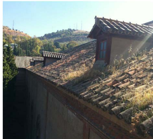
Exterior de la cubierta del tramo 4 por patios
