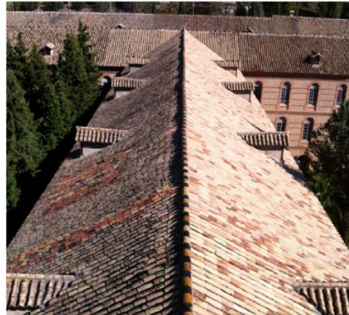
Exterior de la cubierta del tramo 4. Vista superior.
