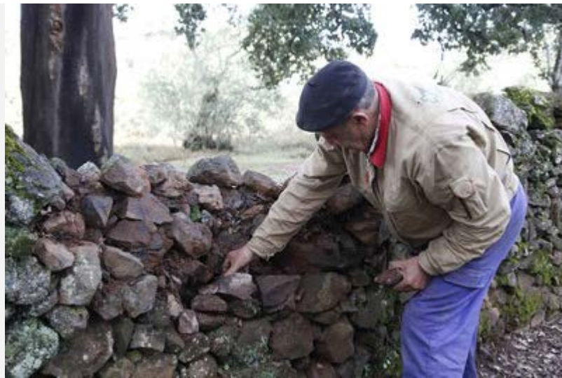
Reparando un muro (Aracena). Autor: Aniceto Delgado.
