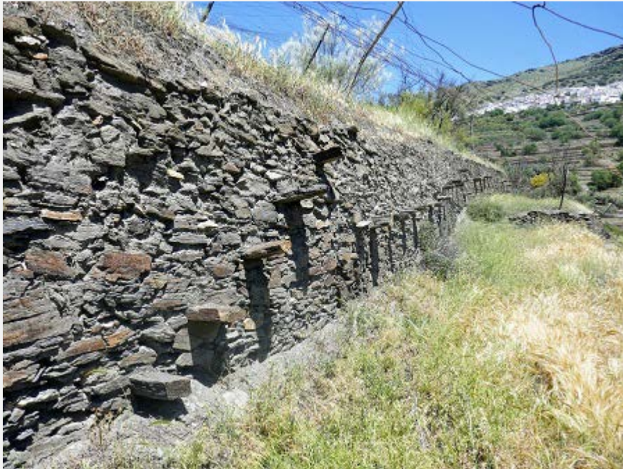
Imagen 4: El pueblo de Ohanes al fondo y muro de piedra seca sobre el que aún pueden observarse restos de alambres de las estructuras parraleras. Fuente: fotografía cedida por Francisco Javier Martínez Rodríguez.
