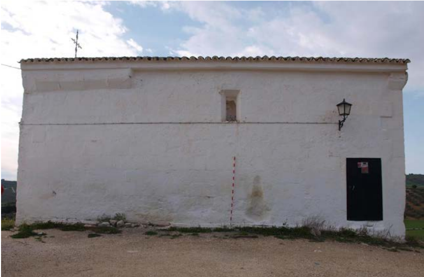
Fig.4. Rebaje exterior de los sillares del muro S.
