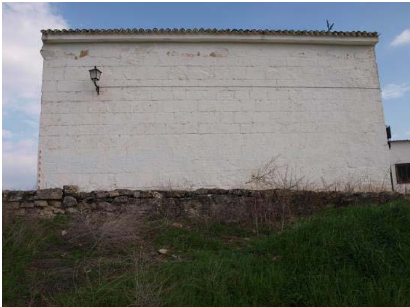
Fig. 5. Vista de la Ermita desde el Oeste y Norte.
