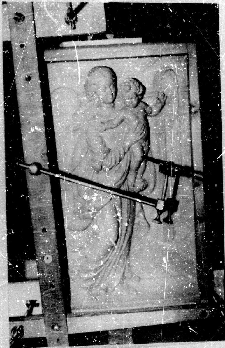
Fig. (1.) A. Barbero: Ejemplo de maquinilla de sacar de puntos sujeta al tripode donde se advierten los puntos de anclaje.
