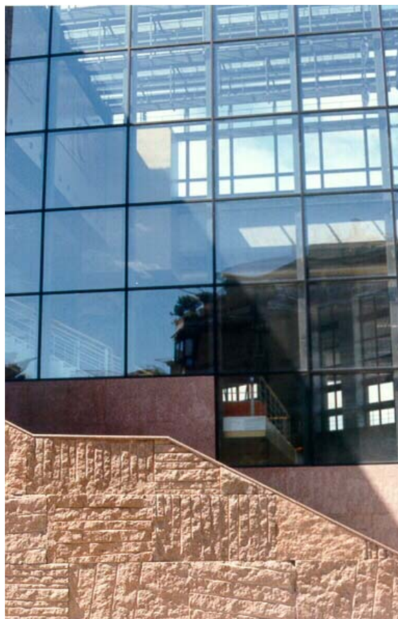
Ornamentación definida por los materiales de revestimiento. Palacio de Congresos de Granada.
