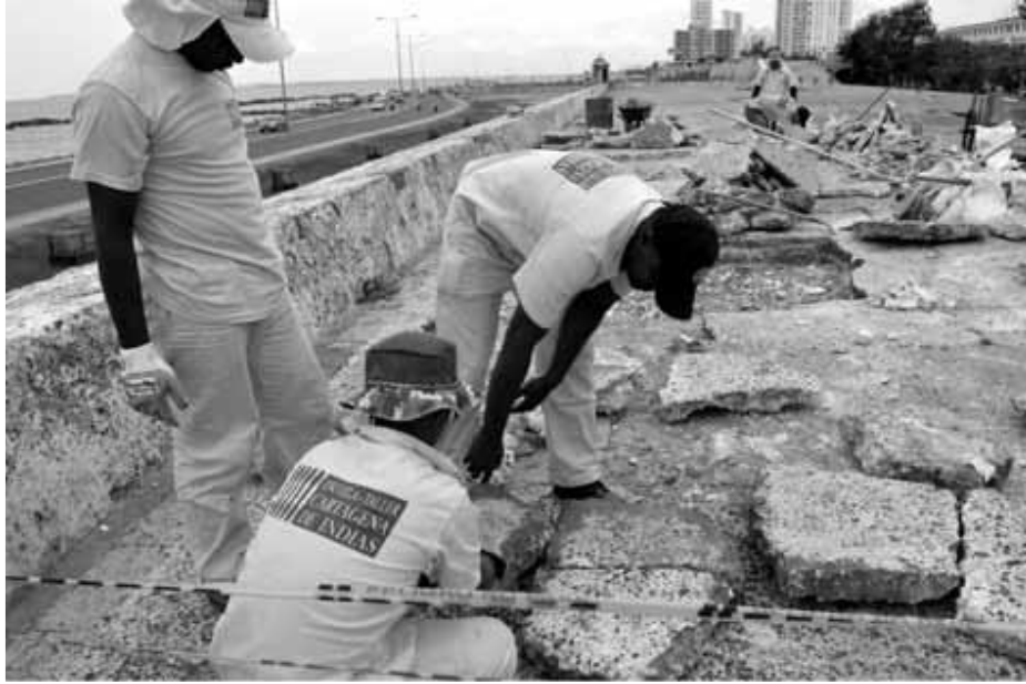
Figura 147. Consolidación de la superficie de la plataforma del Baluarte Santa Clara, Agosto y Septiembre de 2014
