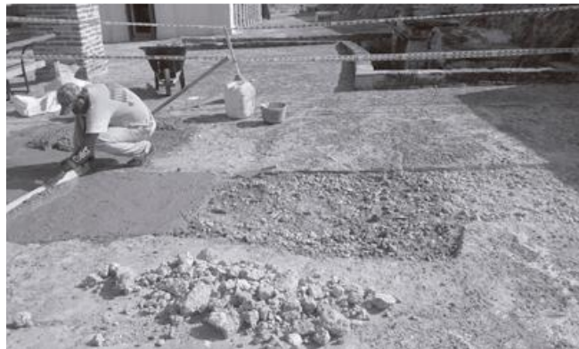
Figura 148. Refacción de juntas en solados y rampas
