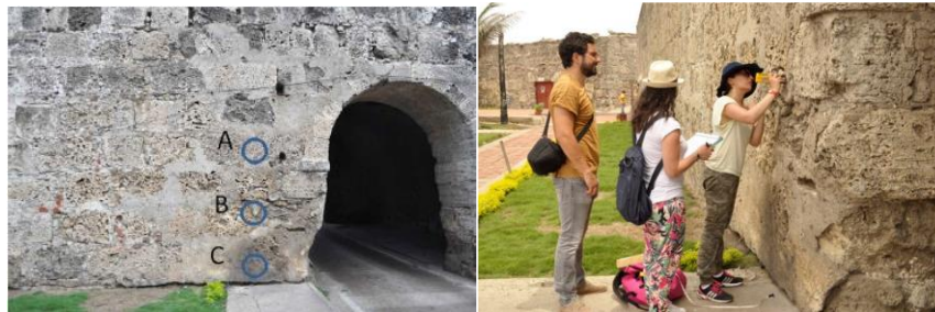
Figura 170. Localización y toma de datos en zona de estudio de la puerta en el baluarte de Santo Domingo
