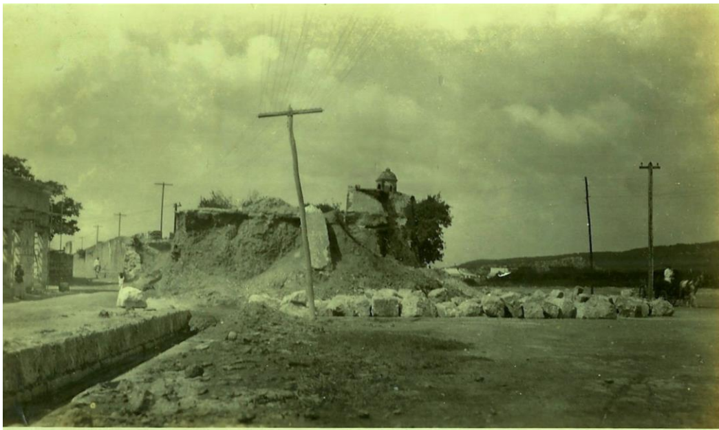
Figura 140. Baluarte San Andrés demolido
