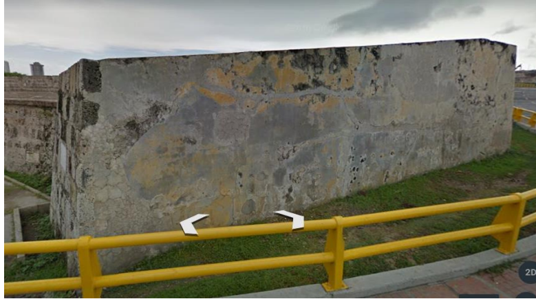
Figura 125. Baluarte Santa Teresa Vista Lateral
