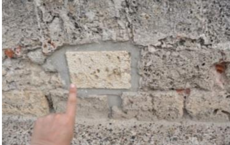
Figura 177. Localización de toma de mediciones en la piedra actual utilizada en la conservación y restauración del Baluarte de Santodomingo
