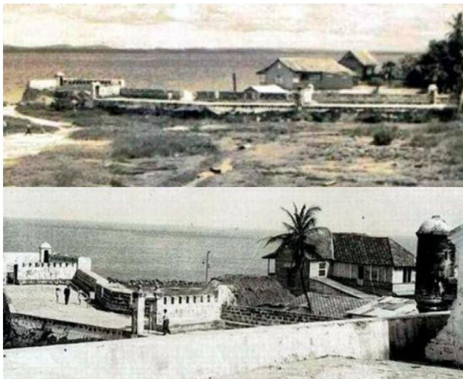
Figura 143. Casas en El Cabrero adosadas al Espigón del Baluarte de Santa Catalina
