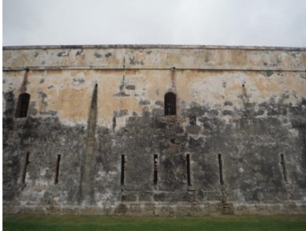
Figura 96. Bóvedas (Vista desde la Avenida Santander)
