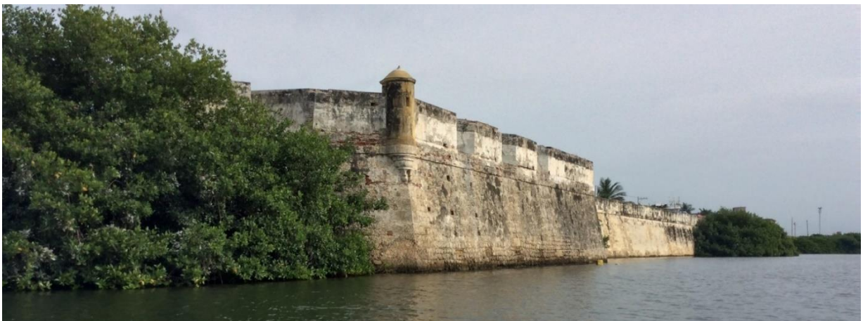
Figura 128. Baluarte San José Vista Lateral
