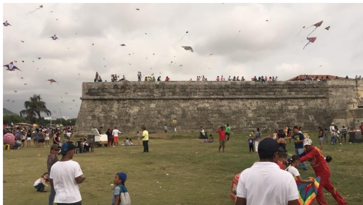
Figura 53. Sobrecarga ejercida sobre las murallas por eventos públicos
