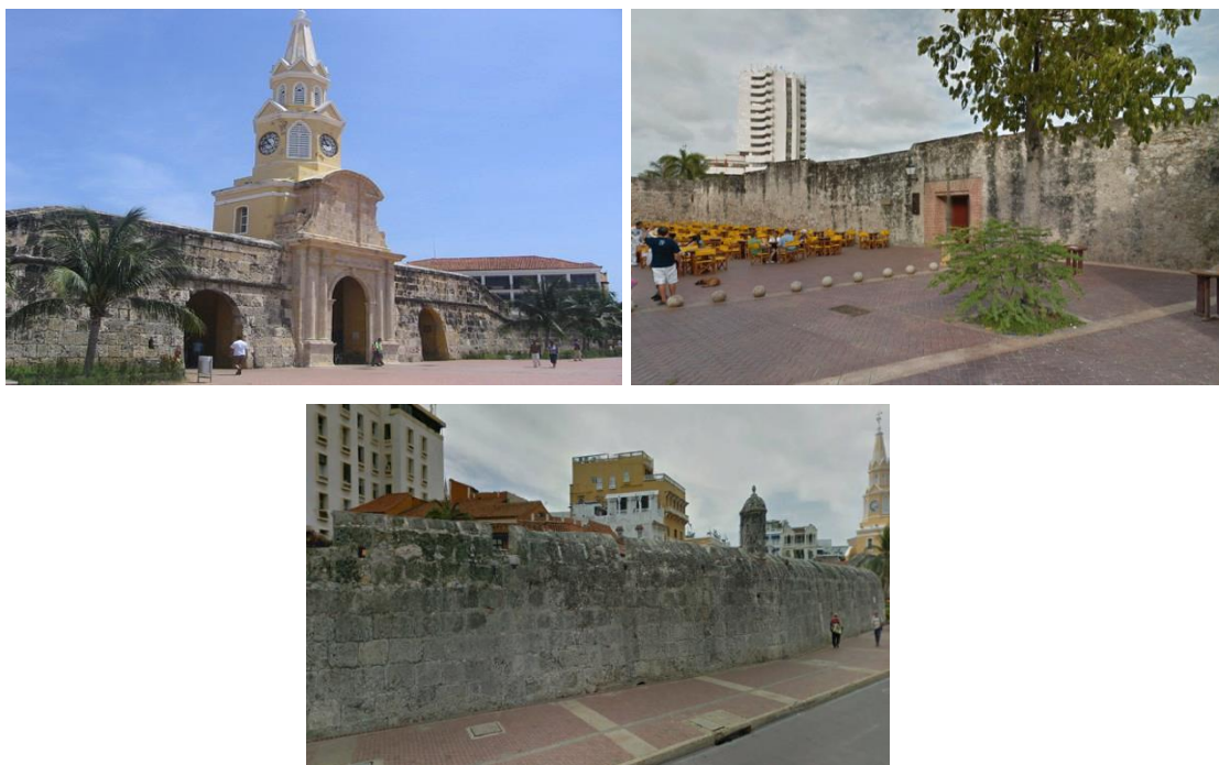
Figura 69. (Izq.) Baluarte de la Contaduría (Vista de la torre del reloj). (Centro) Vista Baluarte de la Contaduría. (Der.) Baluarte de la Contaduría
