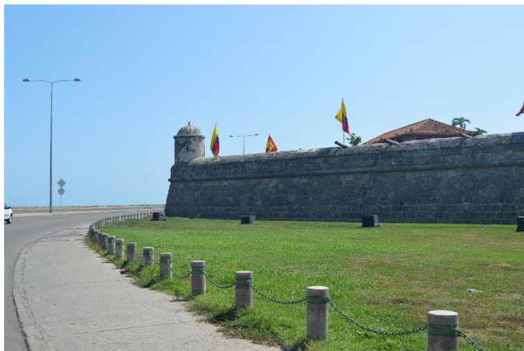
Figura 150. Elaboración de 1.314 bolardos instalados a lo largo de 1.970 m 2 para cerramiento de las zonas verdes exteriores en las murallas de Cartagena
