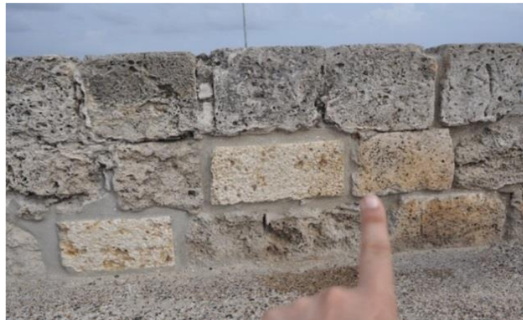
Figura 179. Localización de toma de mediciones en la piedra utilizada en restauraciones antiguas del Baluarte de Santodomingo
