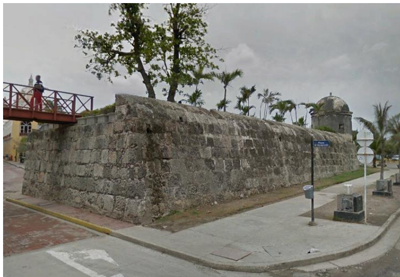
Figura 79. Baluarte San Francisco vista desde el acceso sobre la Avenida Santander
