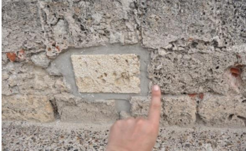
Figura 174. Localización de la toma de humedades y temperaturas piedra original baluarte de Santodomingo
