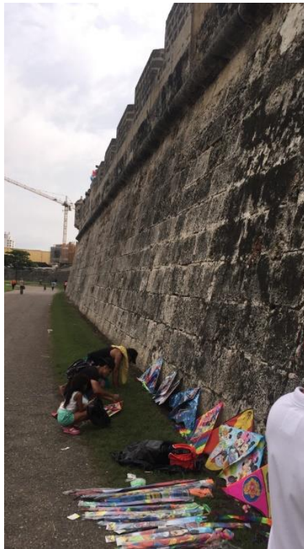
Figura 60. Uso de venta informal en las cortinas del cordón amurallado
