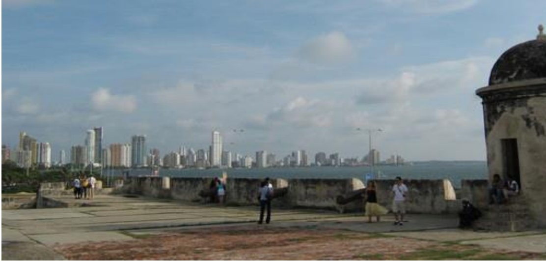
Figura 81. (Izq.) Baluarte Santiago Apóstol (Vista desde la plataforma)
