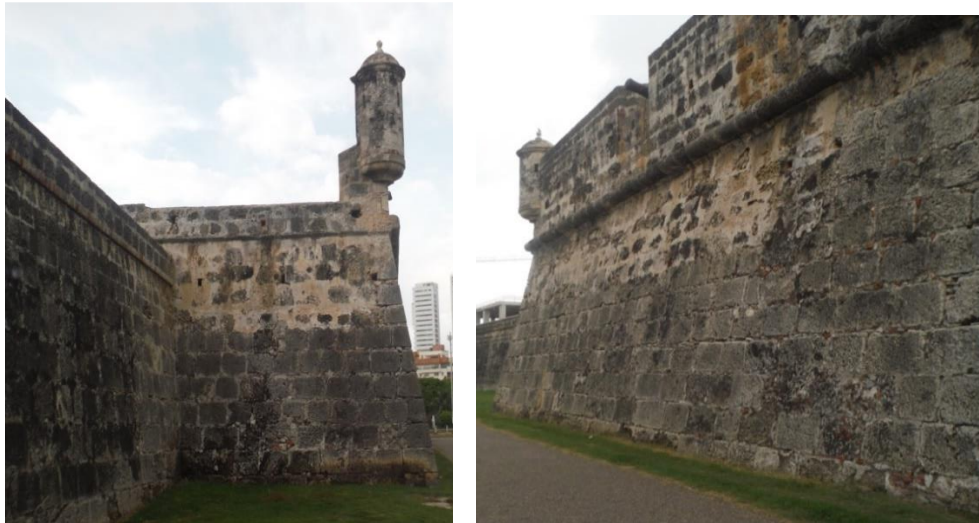
Figura 113. (Izq.) Baluarte San Lucas. (Der.) Baluarte San Lucas vista Lateral
