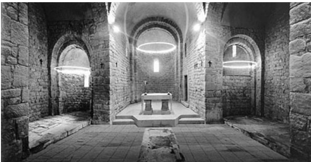
Ilustración 5. Iglesia de Sant Cugat del Racó, Navàs (Barcelona). Trampantojo para la recuperación de la cabecera de tres ábsides. Foto, SPAL, Diputación de Barcelona
