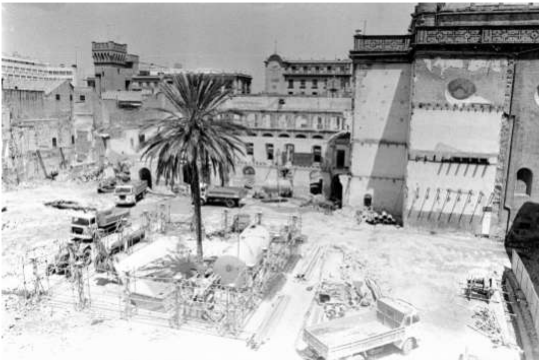
Link 09. Demolición de la antigua Casa Profesa jesuita. ICAS-SAHP, Fototeca Municipal de Sevilla, Archivo fotográfico Serafín. Sin fecha. Datable en 1971.
