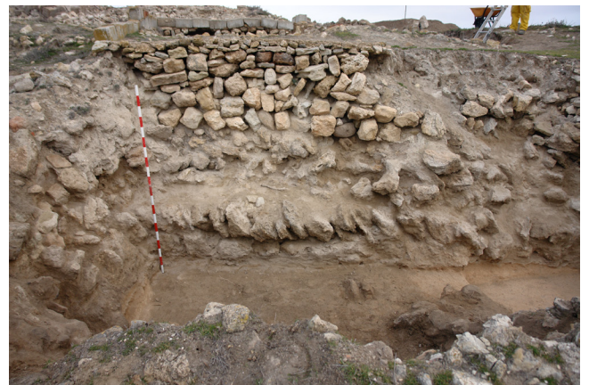
Fig. 9 - Muro de refuerzo en el corte 25 (1f) con el sistema de mampostería en espina de pez en las hiladas de base (foto: C. Pérez).
