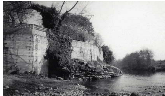
Protección con muro de hormigón. Fuente: UC, 1999
