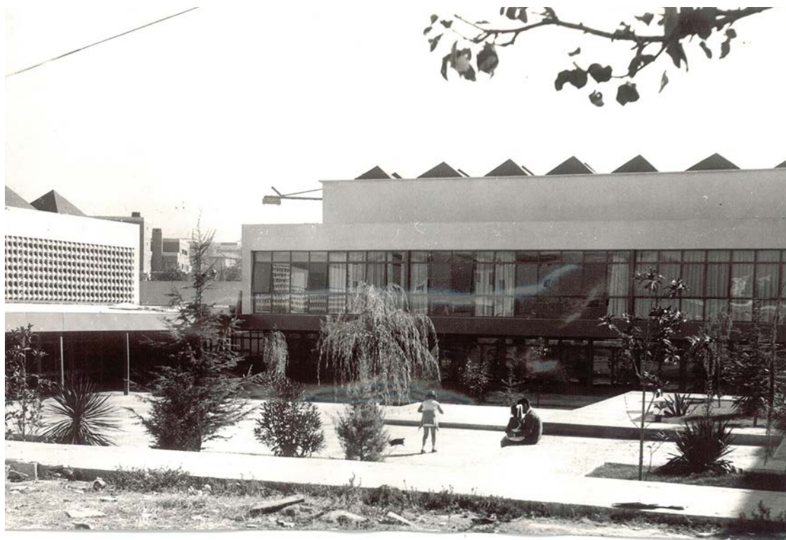
Manuel Torres Molina Vista parcial de la Facultad de Ciencias
