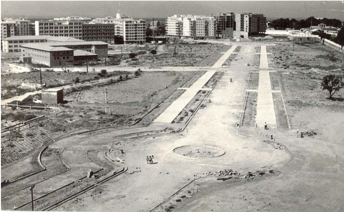
Manuel Torres Molina Vista de las obras de construcción del Campus Fuentenueva
