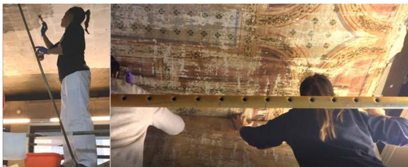
Figura 4. Proceso de protección de la pintura del techo y posterior extracción de ésta. La extracción de la pintura puso al descubierto una decoración subyacente, pintada sobre el cielo raso de la estancia principal de la farmacia.
