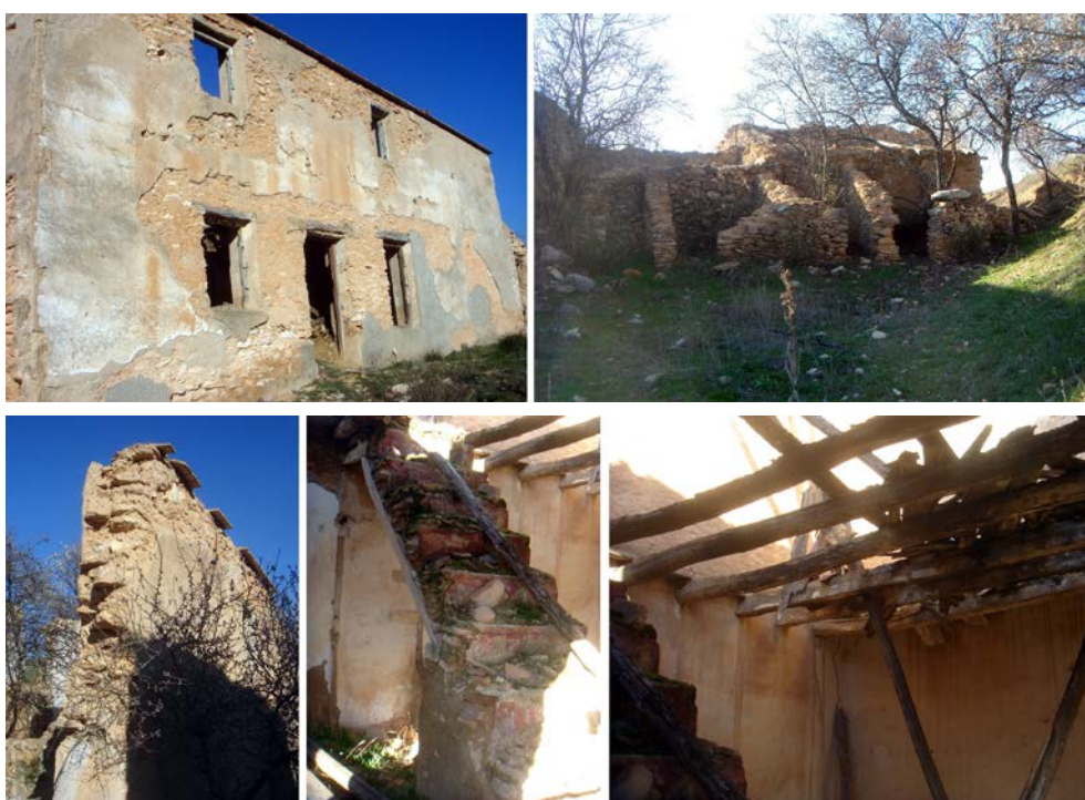
Imágenes de la fachada principal, cobertizos, y restos de muros, escaleras interiores y forjado de madera.
