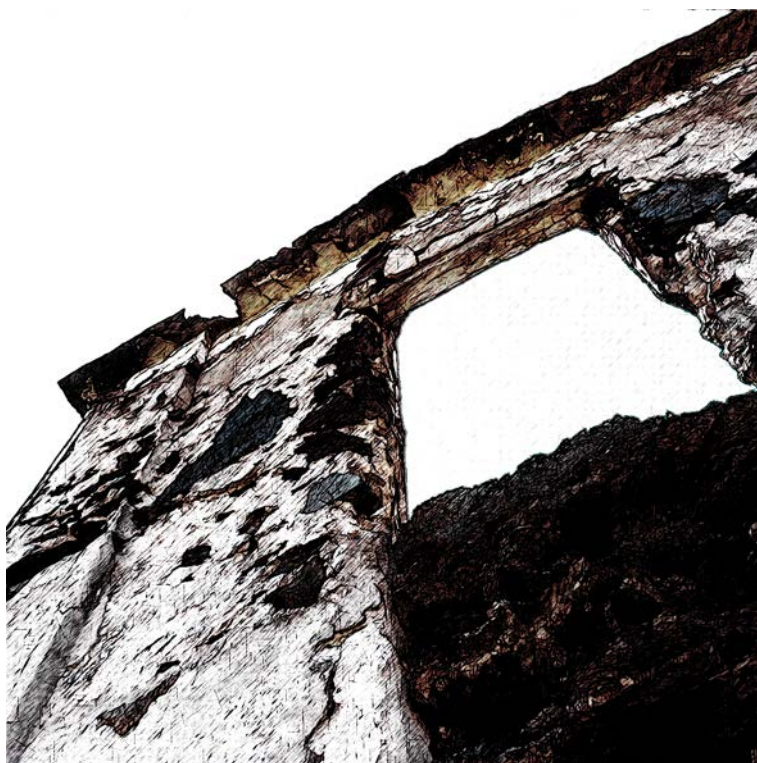
4 El vacío. La acumulación de piedras sueltas y semisujetas levemente de lo que antes eran muros de viviendas.
