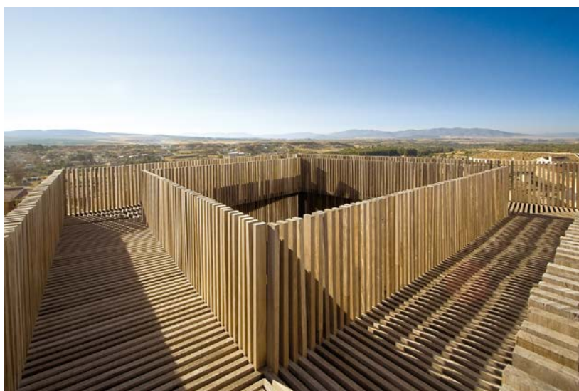
Imágenes del exterior y mirador de la Torre del Homenaje rehabilitada de Huéscar.
