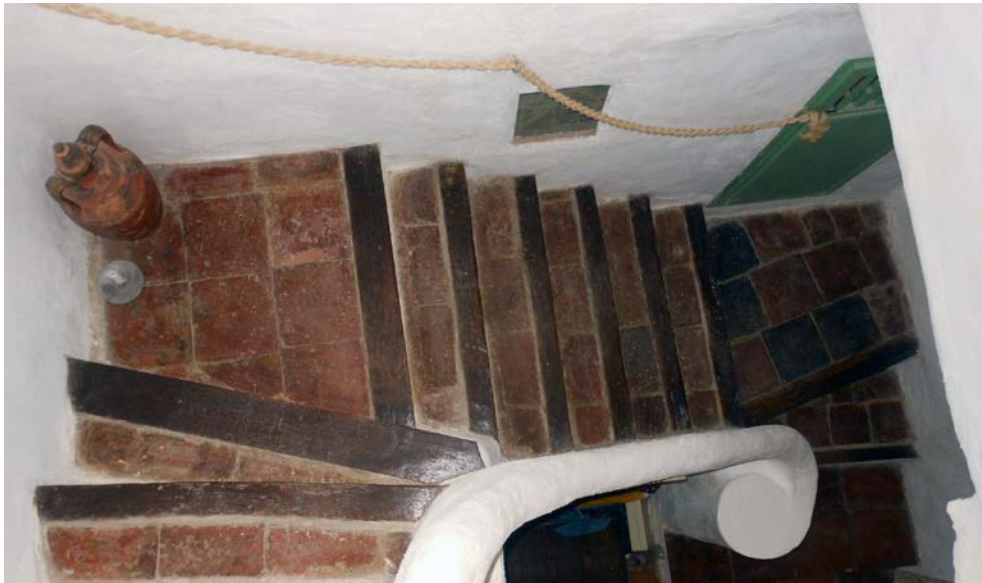
Escaleras centrales de conexión de baldosas de barro, mamperlán de madera y peto de fábrica de ladrillo encalado con dibujo enrollado.
