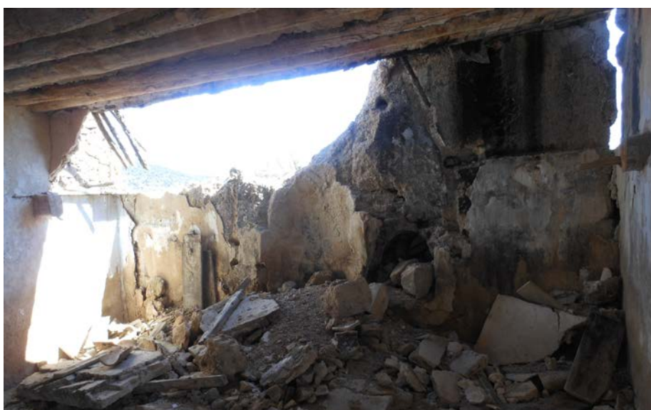
Imágenes del cortijo Girón. Exterior, puerta de acceso e interior del salón principal.
