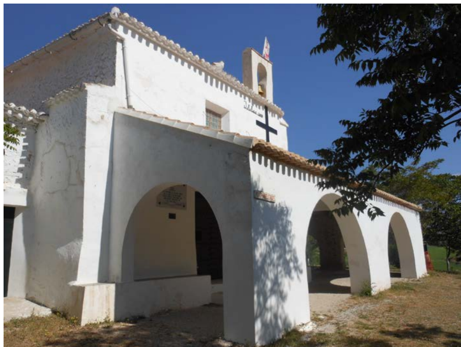
Vista de general del acceso a la ermita desde la explanada de entrada.
