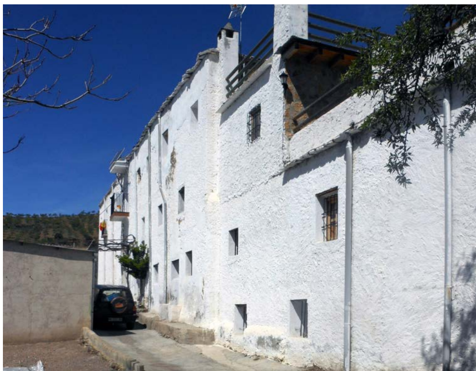
Vista exterior de la fachada principal desde el sureste.
