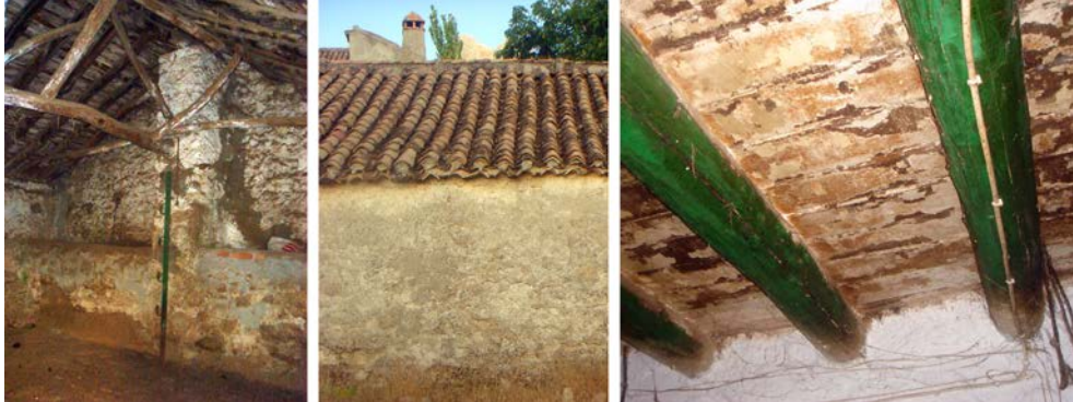
Imágenes estructura madera anexos, revestimiento de mortero de cal y forjados de madera del Moralejo.
