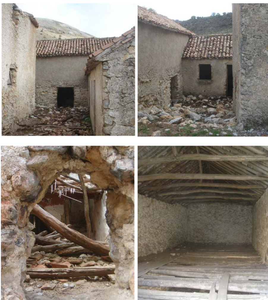
Vistas calle interior del Cortijo de la Tejera. Muros de carga y forjados de madera
