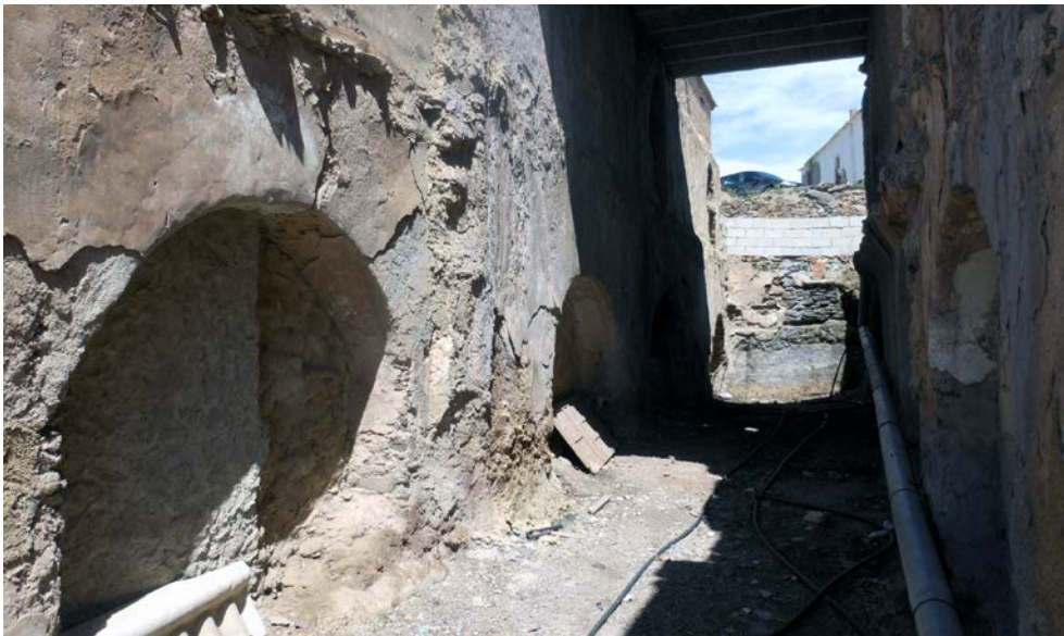
Imagen de la calle interior semicubierta estructurada en arcadas de mampostería.
