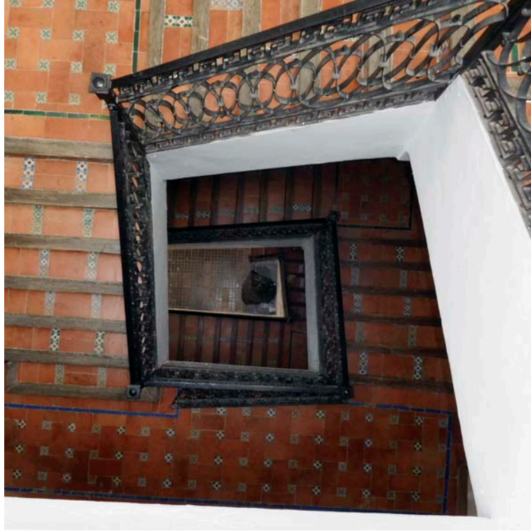
7 Caserón decimonónico de gran escala. Escaleras interiores y aljibe.
