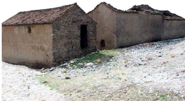
7 Muros de piedra con revoco de cal grasa.
