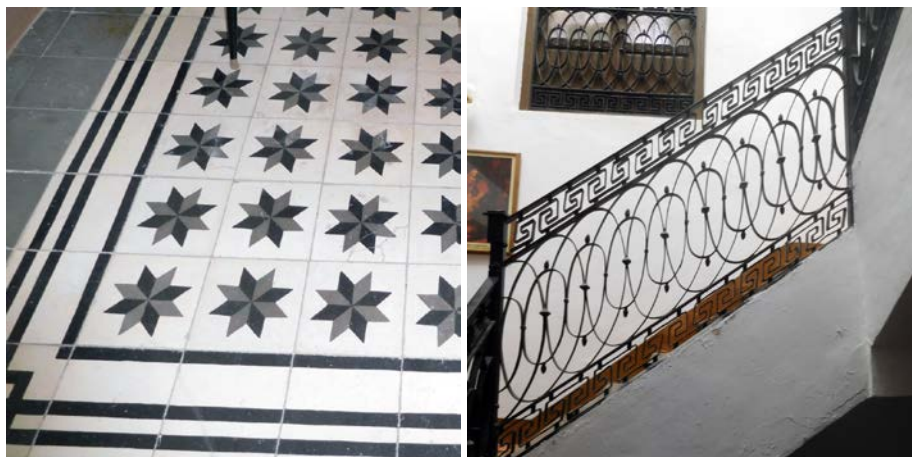
Imágenes del pavimento principal de baldosa hidráulica y barandilla del núcleo escaleras centrales.
