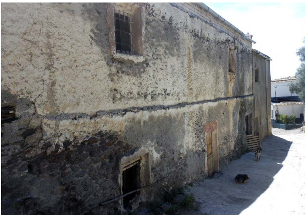
Vista de la vivienda 2 del cortijo del Malagueño alineada al camino dirección Albondón.
