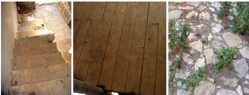
Imágenes escalera y pavimento casa el pastor. Empedrado plazoleta de acceso del Cortijo del Moralejo.
