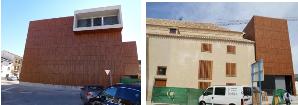
Imágenes de la rehabilitación del convento en la parte trasera del edificio original.
