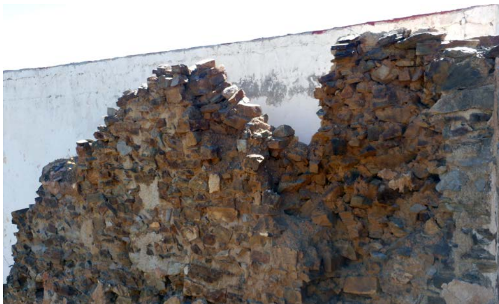
Contraste de restos de muros antiguos con los nuevos de la vivienda 1 del cortijo de los Rafaelés.
