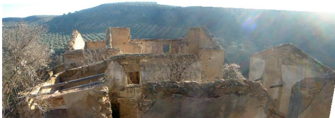
Vista de los restos del Cortijo de la Paloma desde la fachada norte y fondo el río Blanco.
