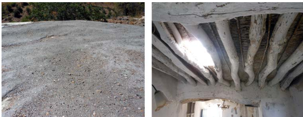
Cubierta de launa en Los Rafeles y forjado de rollizos de álamo con cañizo de La Casería del Redador.
