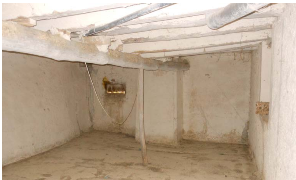
Vista volumen principal hacia explanada trasera del cortijo Cubero e interior.
