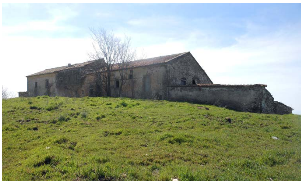
Vista general fachada noroeste Venta del Pilar.
