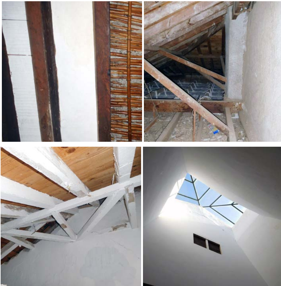
Imágenes forjado de madera, formación de cubierta inclinada, cruces de San Andrés y lucernario.
