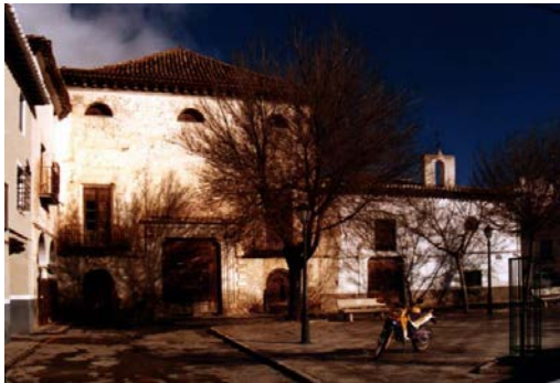
Fachada principal antes de su rehabilitación.
