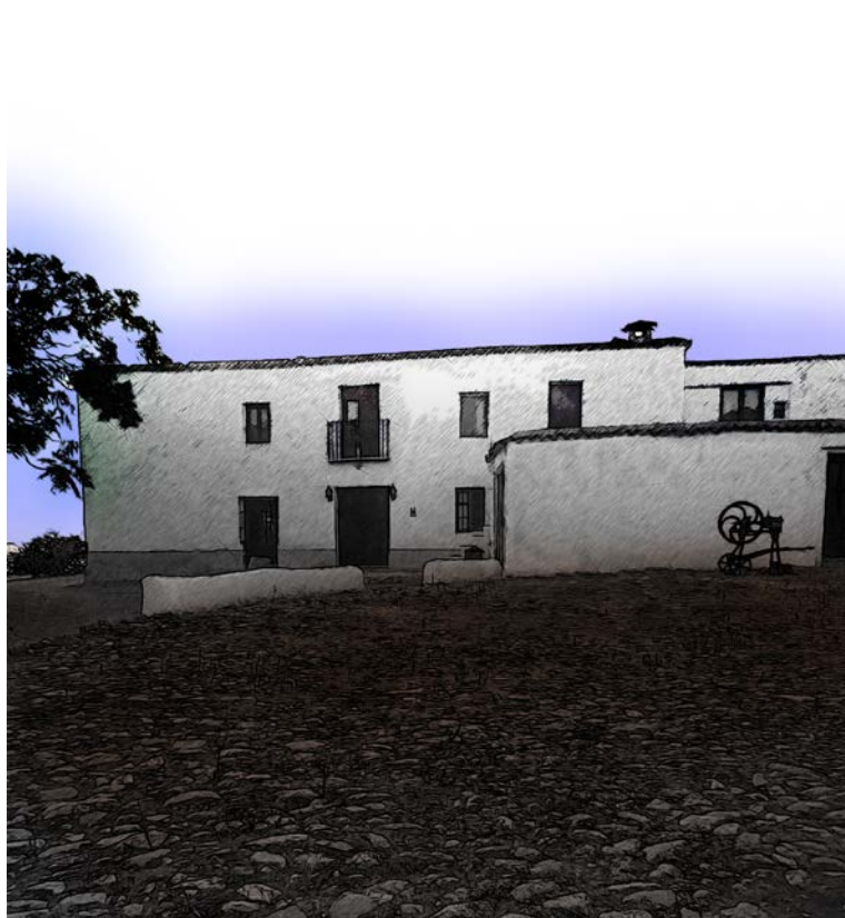
4. Al entrar al camino y dentro del cortijo desde la era, domina un arquitectura sencilla plana y doméstica.
