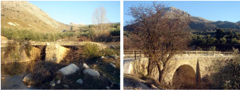
Imágenes del puente antiguo y nuevo del Camino Iznalloz sobre el río Blanco.
