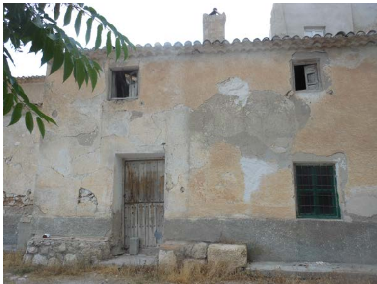
Imágenes del exterior del cortijo de Torralba.
