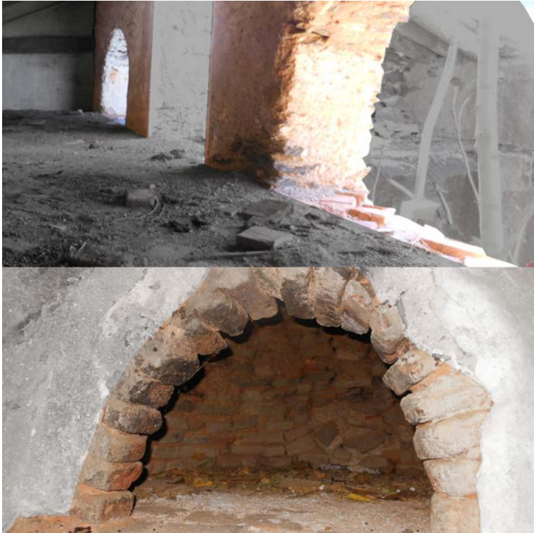
7 Chimenea horno. Muros - arcos.
