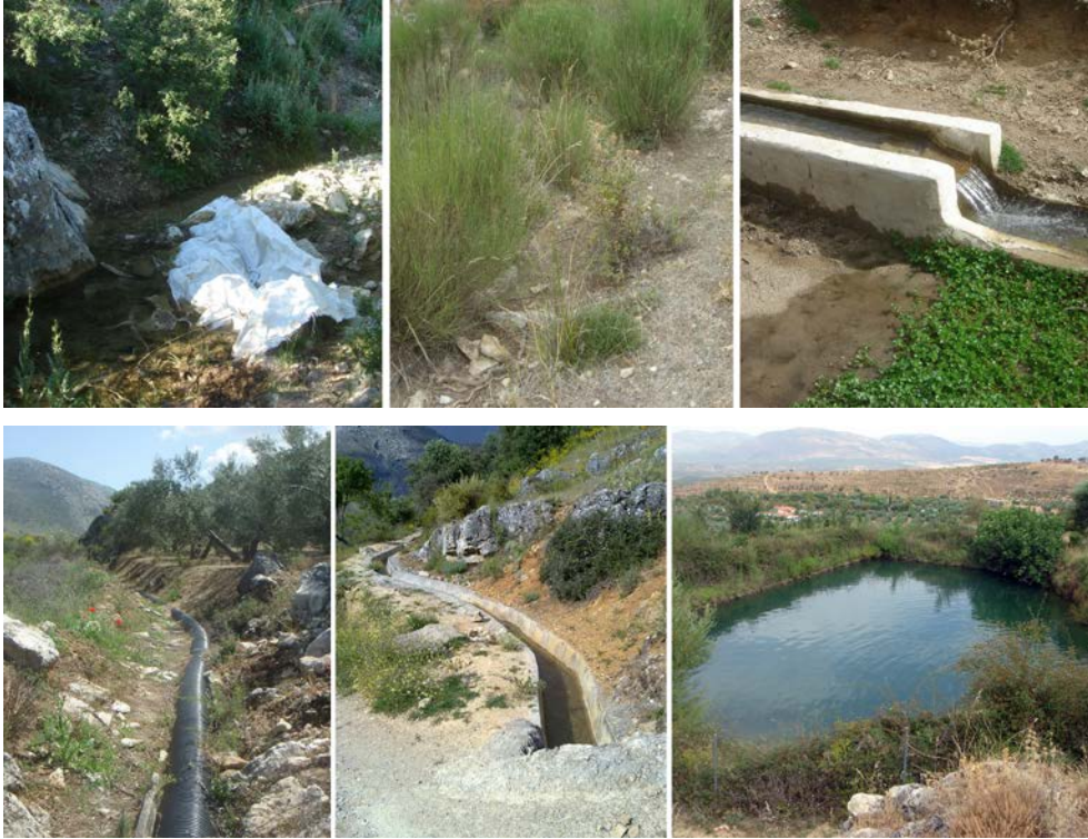
Imágenes de la acequia Moroz desde el Desvío hasta la Balsa de Catacena.
