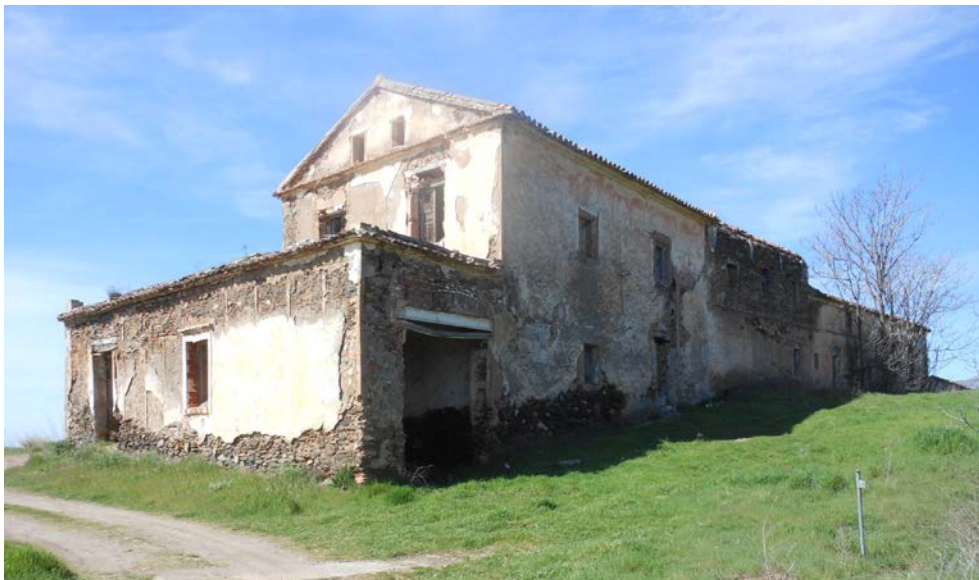
Vista general de la fachada noreste de la Venta del Pilar en Haza del Lino.
