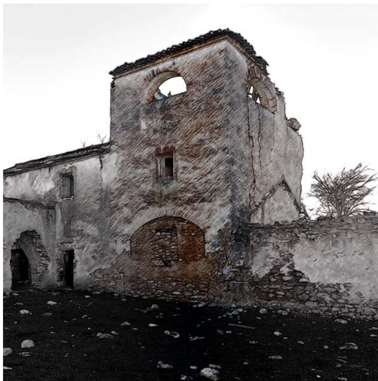
Cortijo Dehesilla. Torreón en avanzado estado de abandono.
