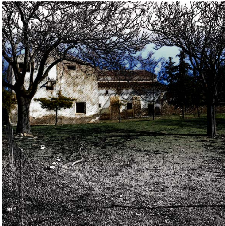
4 Edificio compacto. Invita a conocer. Destaca vista desde plataforma inferior.
