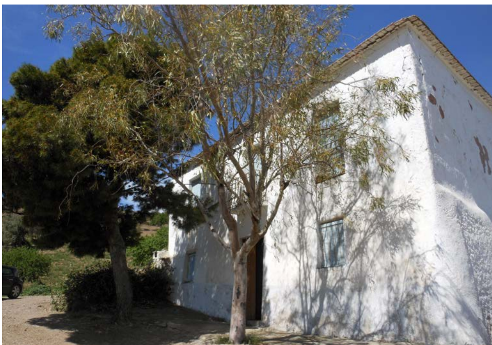
Fachada principal de la vivienda 1 del cortijo del Malagueño.
