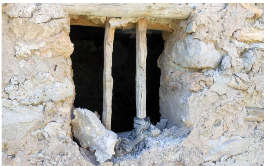
Elementos constructivos: muros de piedra encalados y vistos. Vigas de madera con cañizo.
