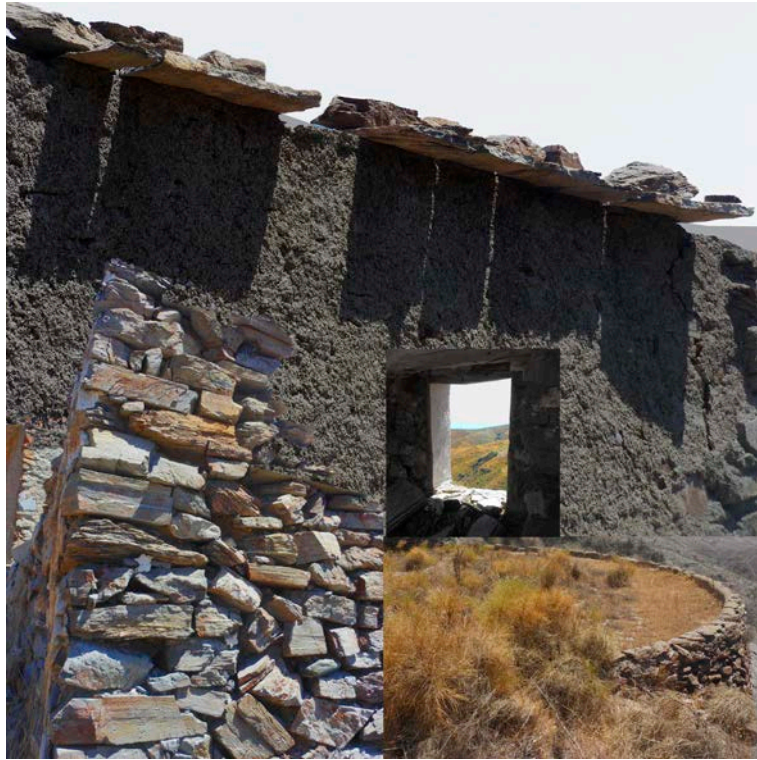
7 Huellas de muros, camino efímero con elementos sueltos, como cornisas de pizarra, habitaciones vacías con vegetación interior, huecos mínimos, pitas, y eras.
