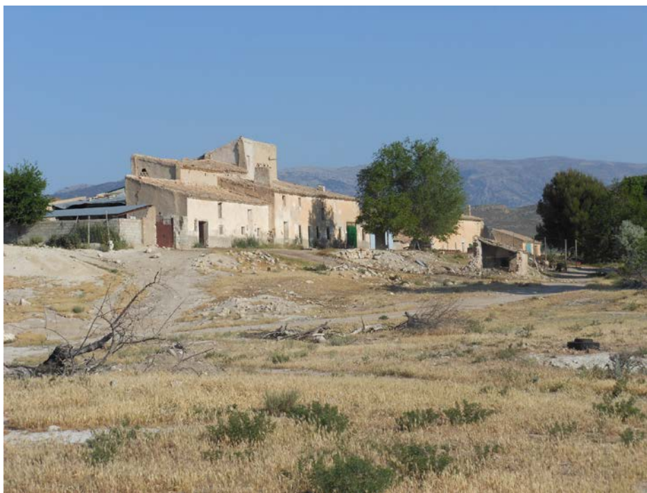
Estado Actual del cortijo de Torralba.
