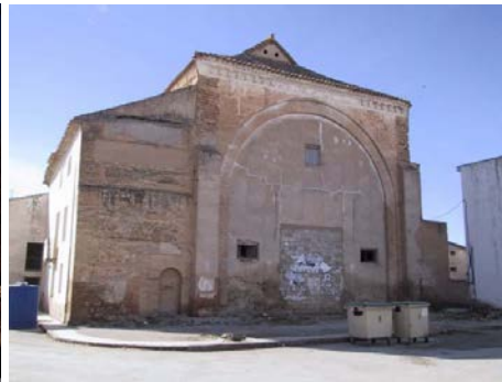
Fachada posterior antes de su rehabilitación.
