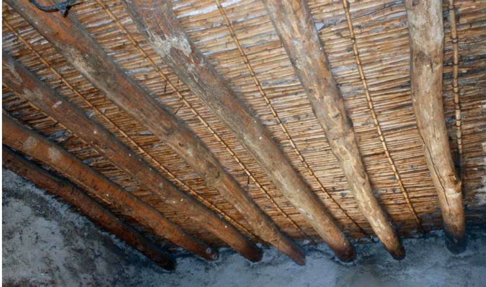
Forjados de rollizos de madera de sección circular con cañizos del Cortijo del Malagueño.
