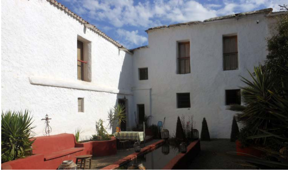
Imagen fachada trasera del cortijo de la Negra.
