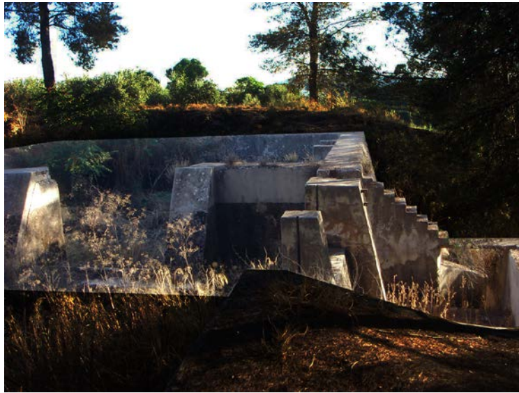
7 Paratas con vegetación, aljibe y estanques.
