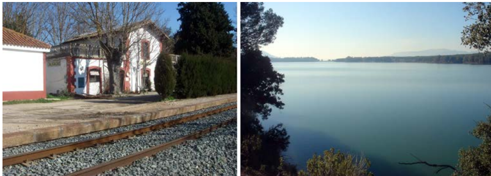
Imágenes del Apeadero de Calicasas y el embalse del Cubillas.
