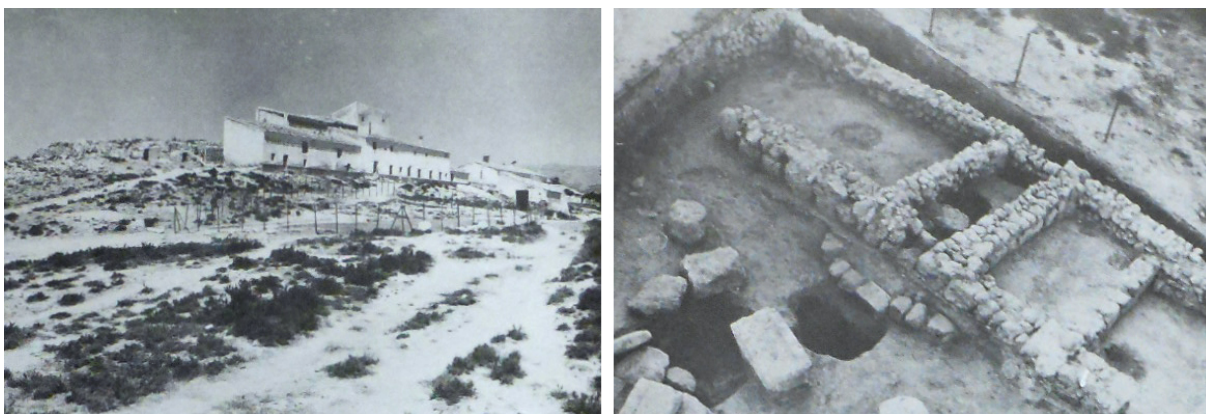
Cortijo de Torralba acotado en las excavaciones realizadas en 1929. 142
