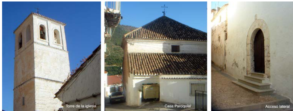
Vistas exteriores de la torre, presbiterio y puerta lateral de la Iglesia de Cogollos Vega.
