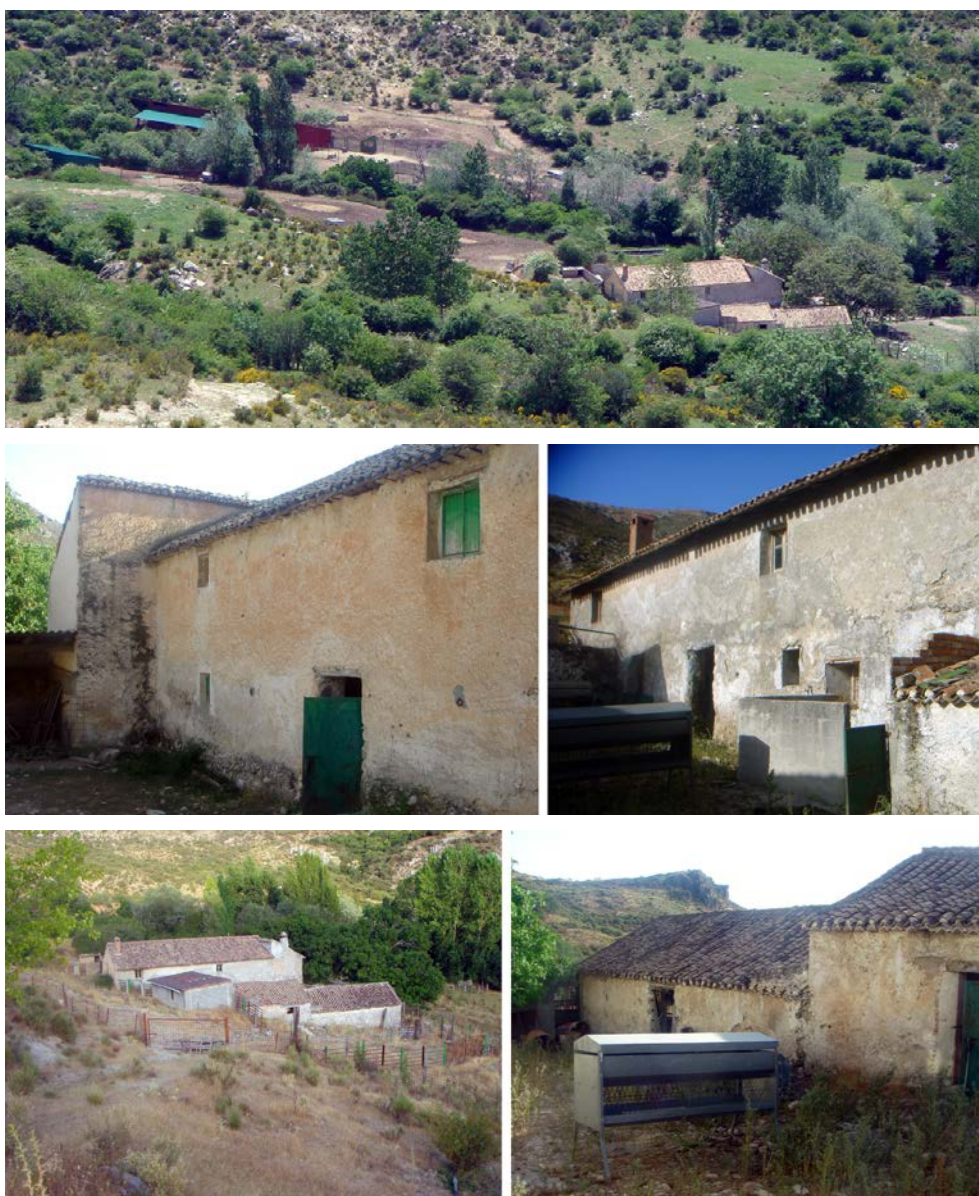
Imágenes desde el norte, patios interiores y fachada oeste del Cortijo del Moralejo.
