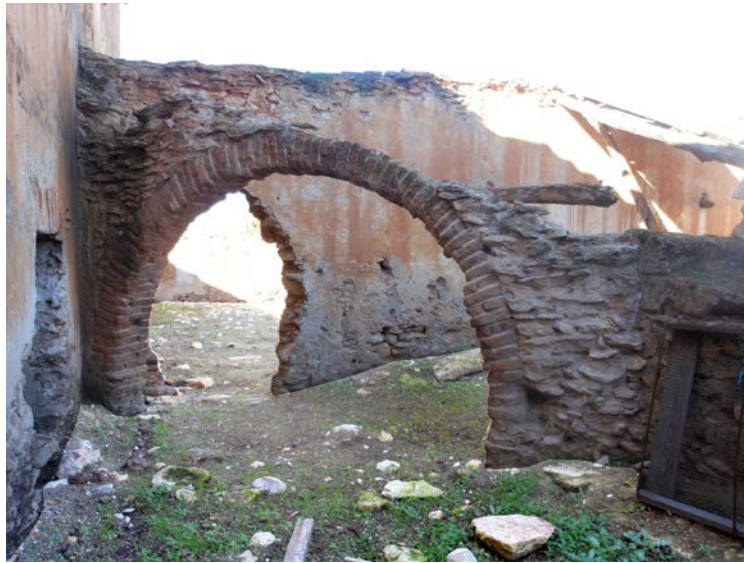
7 Arcos de ladrillo. Aljibe.
