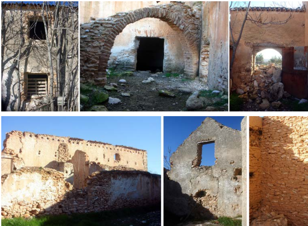
Muros y detalles constructivos del Cortijo de la Dehesilla
