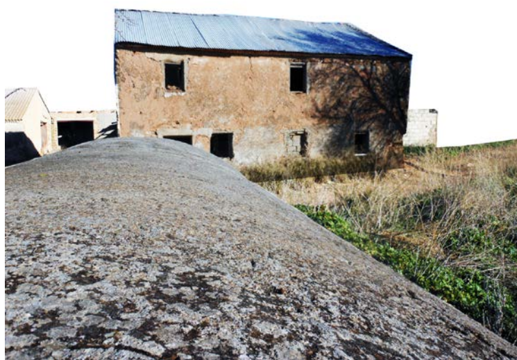
7 Muros del volumen con revoco de cal grasa. Aljibe.
