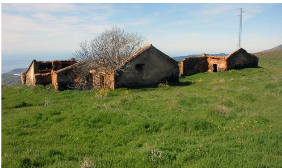
Vista edificaciones anexas al oeste de la Venta del Pilar.
