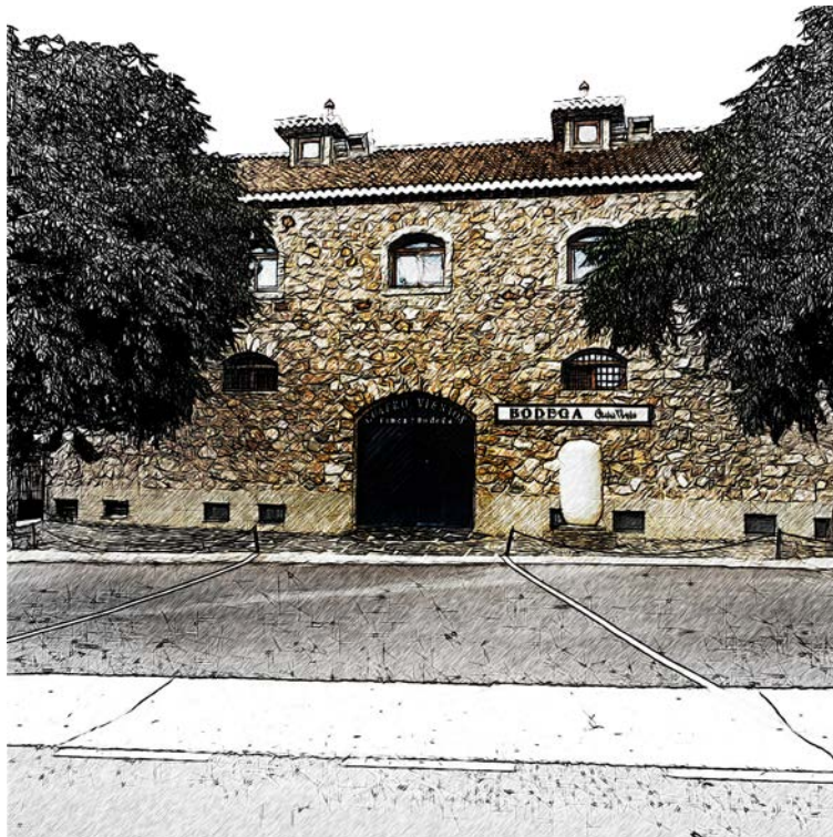
4 Pieza compacta de piedra vista cubierta inclinada con lucernarios con ventanas con arcos rebajados.
