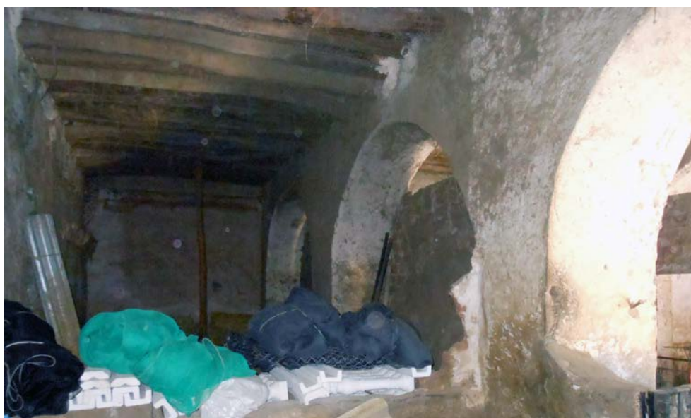
Vista interior de la bodega estructurada con vanos salvados por arcos de medio punto.
