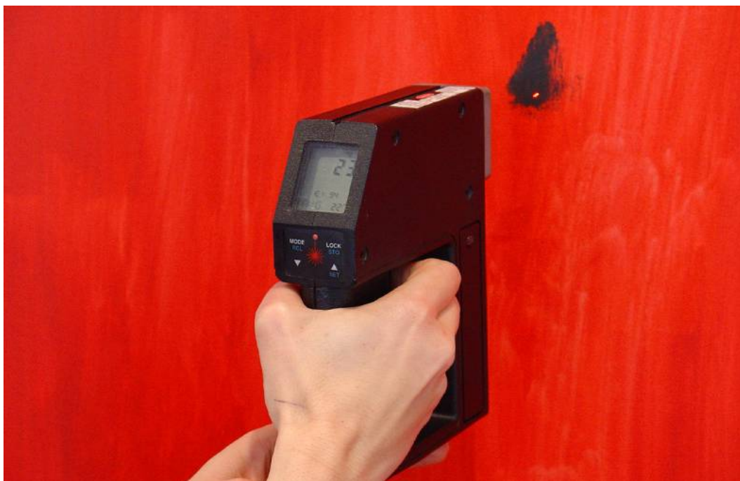
Figura 5.11. Realización de mediciones de temperatura de superficie sobre la obra Oferta con rojo con el Termómetro Portátil Láser de Emisividad Infrarroja Ryatek Inc (Raynger PM 2EM).
