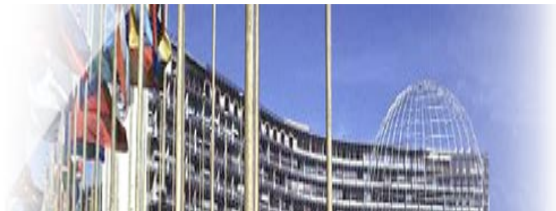
Figura 3.6. Edificio sede de la UNESCO.
