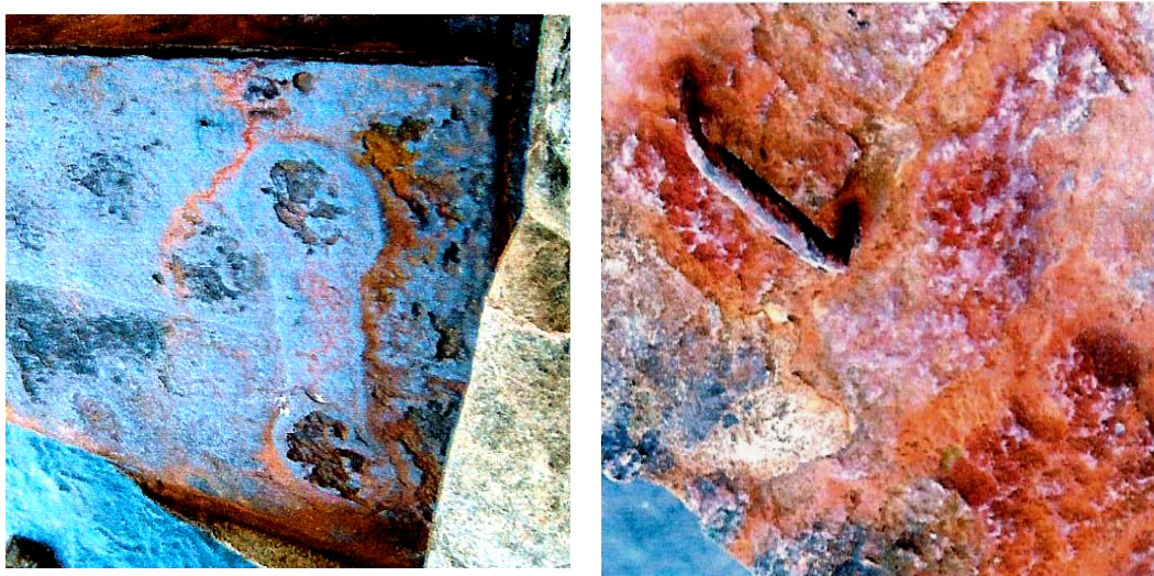
Figura 3.99. Detalle de la capa de oxidación y manchas del Peine del Viento .
