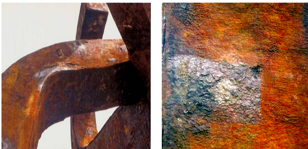
Figura 3.95. Detalles de oxidación y pruebas de limpieza en la superficie del Peine del Viento .
