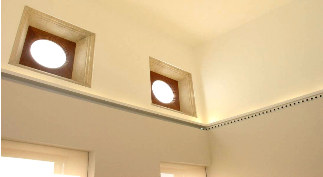
Figura 3.31. Sala de exposiciones del Museo de Bellas Artes de Granada. El proyecto de iluminación incluye la luz natural que entra por los vanos (controlada por estores y filtros) y la luz artificial difusa que se instala sobre una cornisa que posee el muro.
