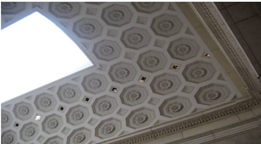
Figura 3.34. Techumbre de una sala de exposiciones del Metropolitan Museum (Nueva York). En ella se encuentran combinadas luz natural cenital, que pasa a través de un gran lucernario, y lámparas de luz artificial situadas entre los casetones de la bóveda.
