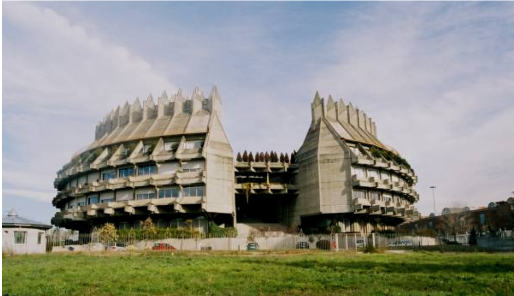
Figura 3.17. Edificio que alberga el IPCE, Madrid.
