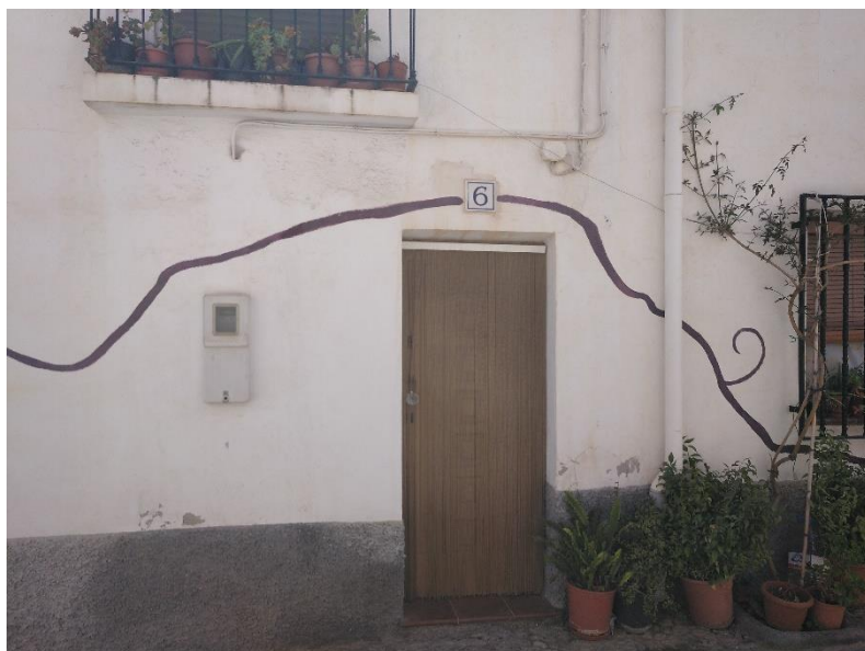
Anexo 27. Parra fachada
