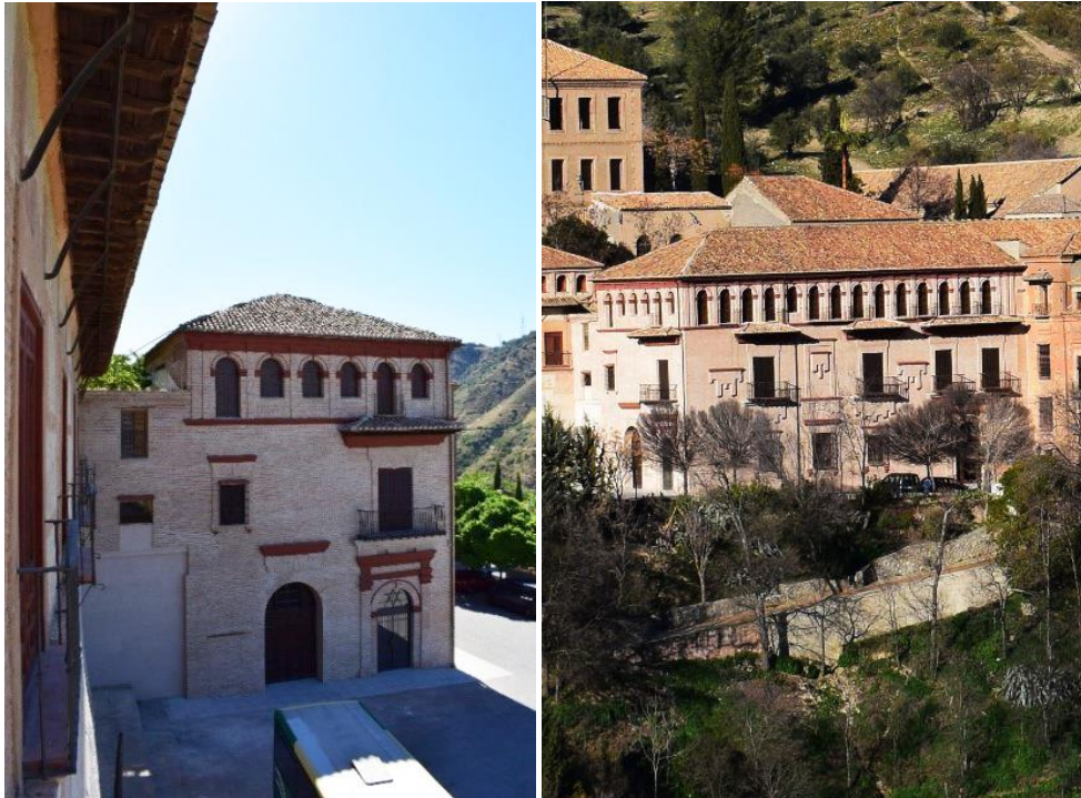
Figura 177. Estado actual del bloque de Jacinto Ruiz Velarde (exterior).
