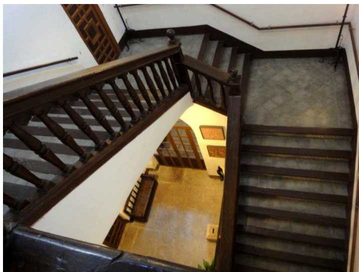
Figura 92. Escalera principal de la Abadía del Sacro Monte.
