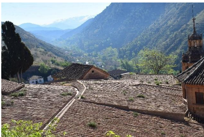
Figura 120. Visión externa del conjunto de las Cuevas enmarcado por el camino de Beas.
