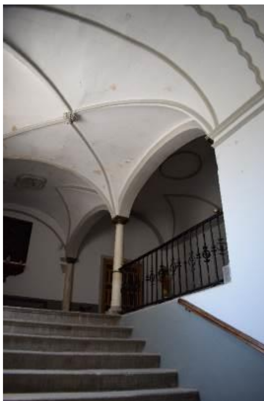
Figura 47. Galería de remate de la escalera del pórtico.
