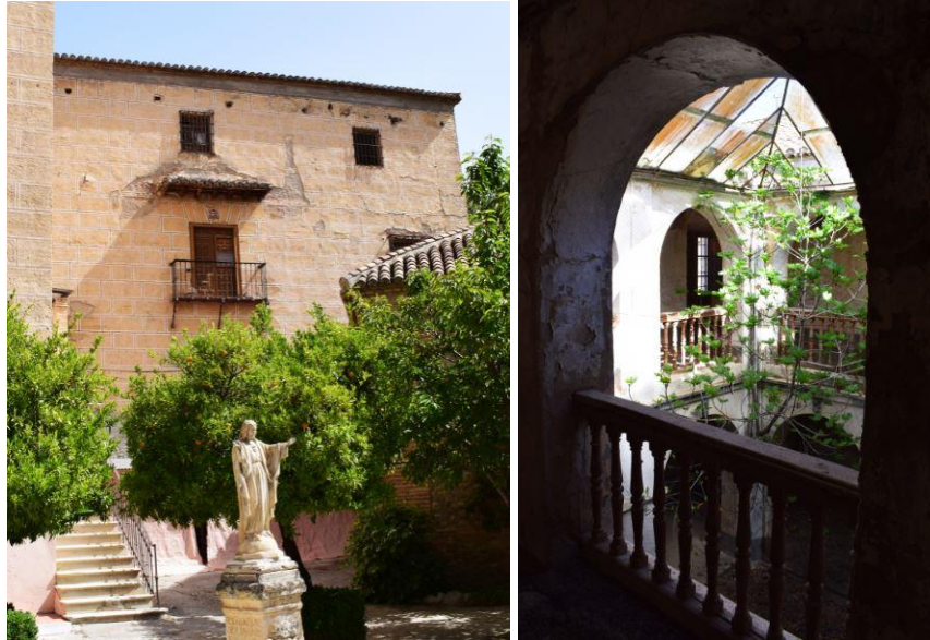
Figura 110. Vista exterior y patio interno del colegio de Diego de Astorga.
