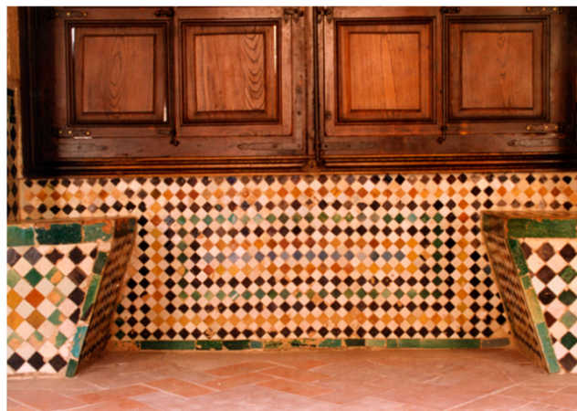
Figure 18. Alicatado panels beneath the mullioned window in the Cuarto Dorado in 1994. © Archivo del Patronato de la Alhambra y Generalife, Photograph Collection, F-14589.
