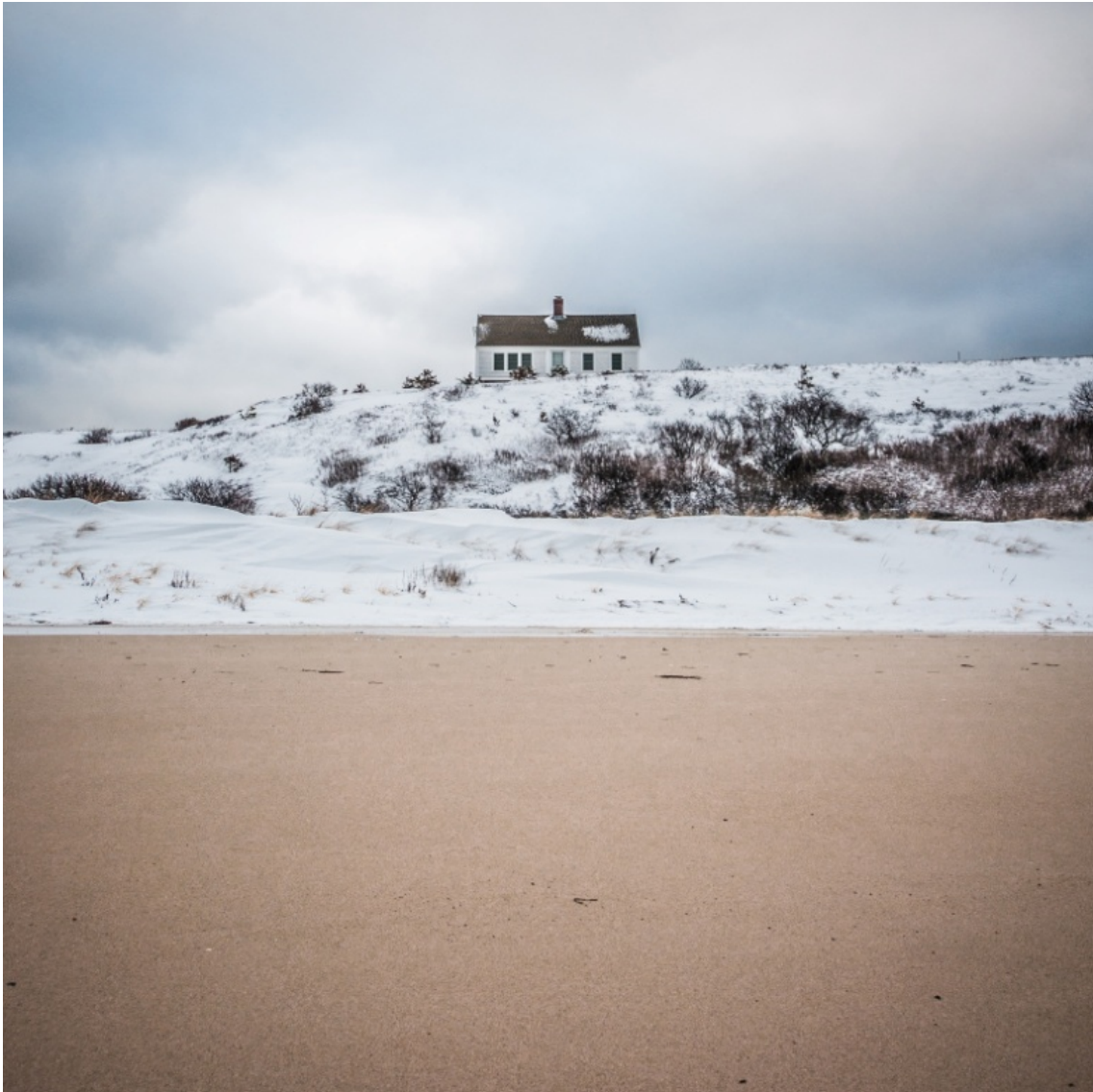
Figura 7: Fachada oeste de la casa-estudio de Edward Hopper en Truro Fuente: J.G. Molinero Sánchez (2016)
