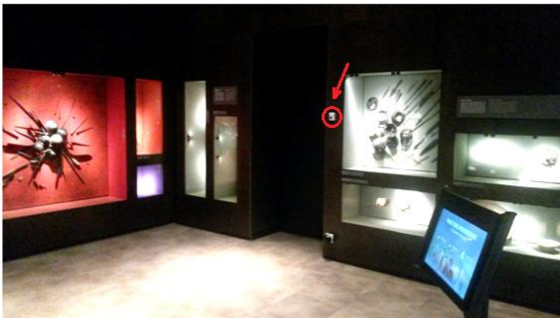
Fig. 149. Una de las puertas de emergencia y botón que permite su apertura
