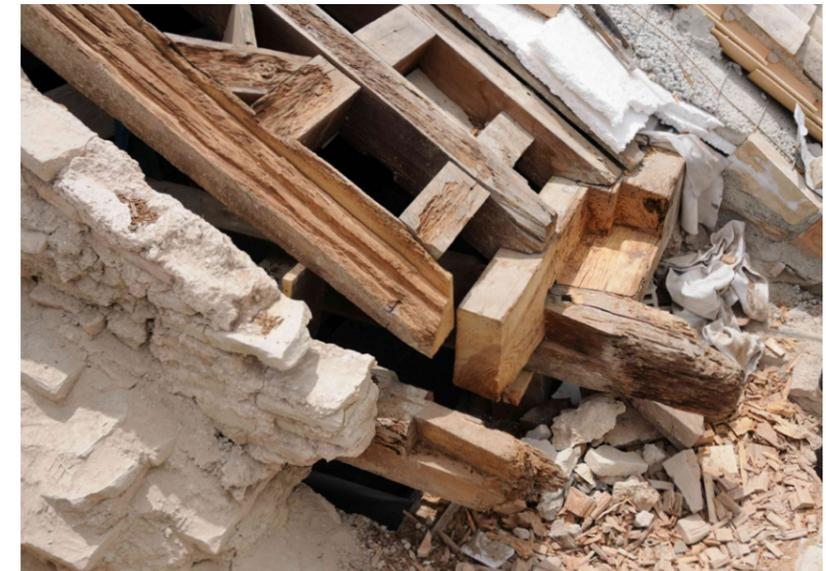
Fig. 21: Disgregación de la madera en el encuentro del artesonado de par y nudillo con el muro (derecha) y con el primer arco (izquierda). Imagen cedida por Luis Anselmo Ibáñez Calero, arquitecto responsable del proyecto de restauración del año 2009.
