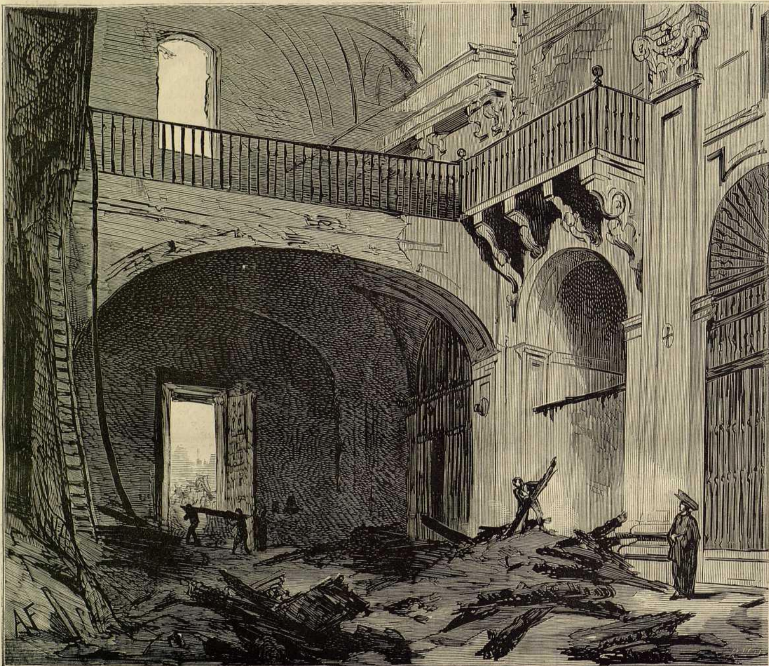
CORO DE LA IGLESIA DE SANTO TOMÁS DESPUÉS DEL INCENDIO.—(MADRID.)
