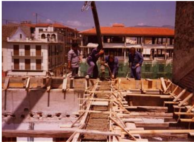
FIG. 8 Solera de hormigón
