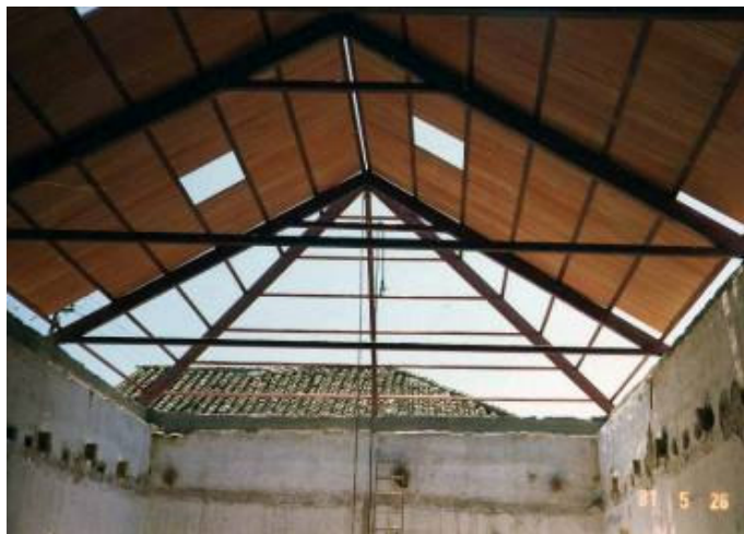
FIG. 9 Instalación de rasillones
