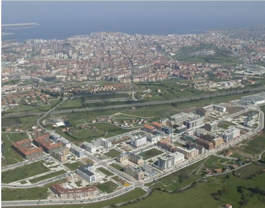
Figura 2.51. Imagen aérea de Gijón, con la urbanización Nuevo Rocés en primer plano. Como se puede apreciar, supone el salto del tejido urbano de la ciudad sobre la autovía del Cantábrico. Fuente: www.sogepso.com
