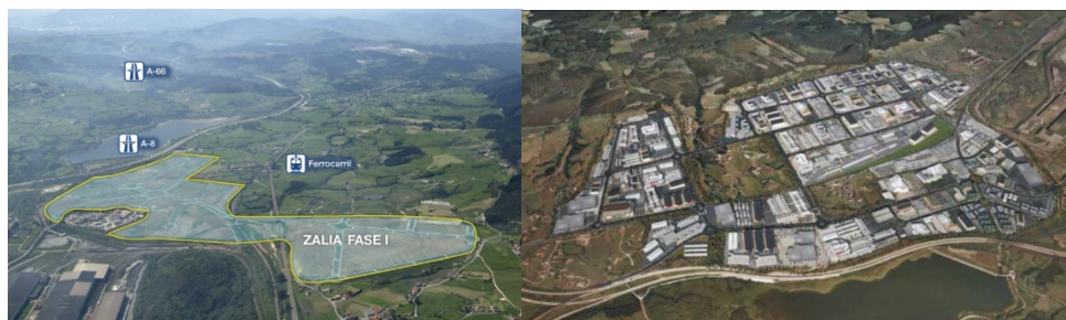
Figura 2.58. A la derecha, recreación del proyecto de la Zona de Actividades Logísticas de Asturias (ZALIA). A la izquierda, terrenos afectados por la primera fase de urbanización de la ZALIA. Fuentes: Fernández Noguerol (2013) y www.zalia.es
