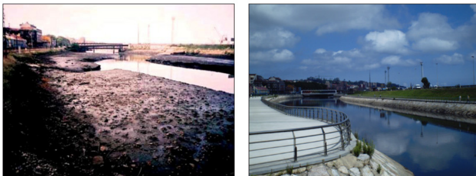
Figura 2.25. Antes y después de un tramo final de la ría de Avilés, tras llevarse a cabo las tareas de recuperación de la misma. Se retiraron los lodos tóxicos presentes en la ría y se realizó su encauzamiento. Esta obra de mejora ambiental ha sido uno de los grandes impulsos del cambio de la imagen urbana de Avilés. Fuente: tomado de Fernández Soto (2013)
