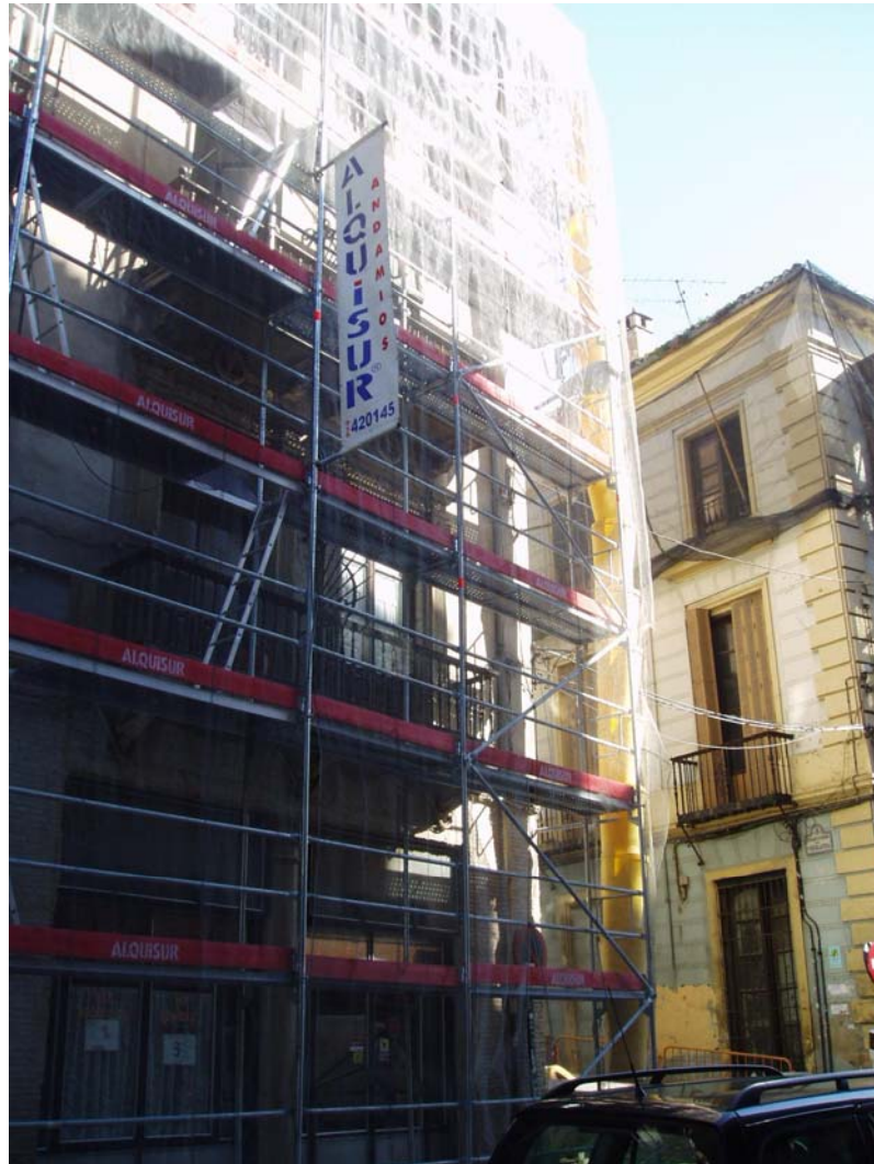
Edificio anexo al museo, en obras
