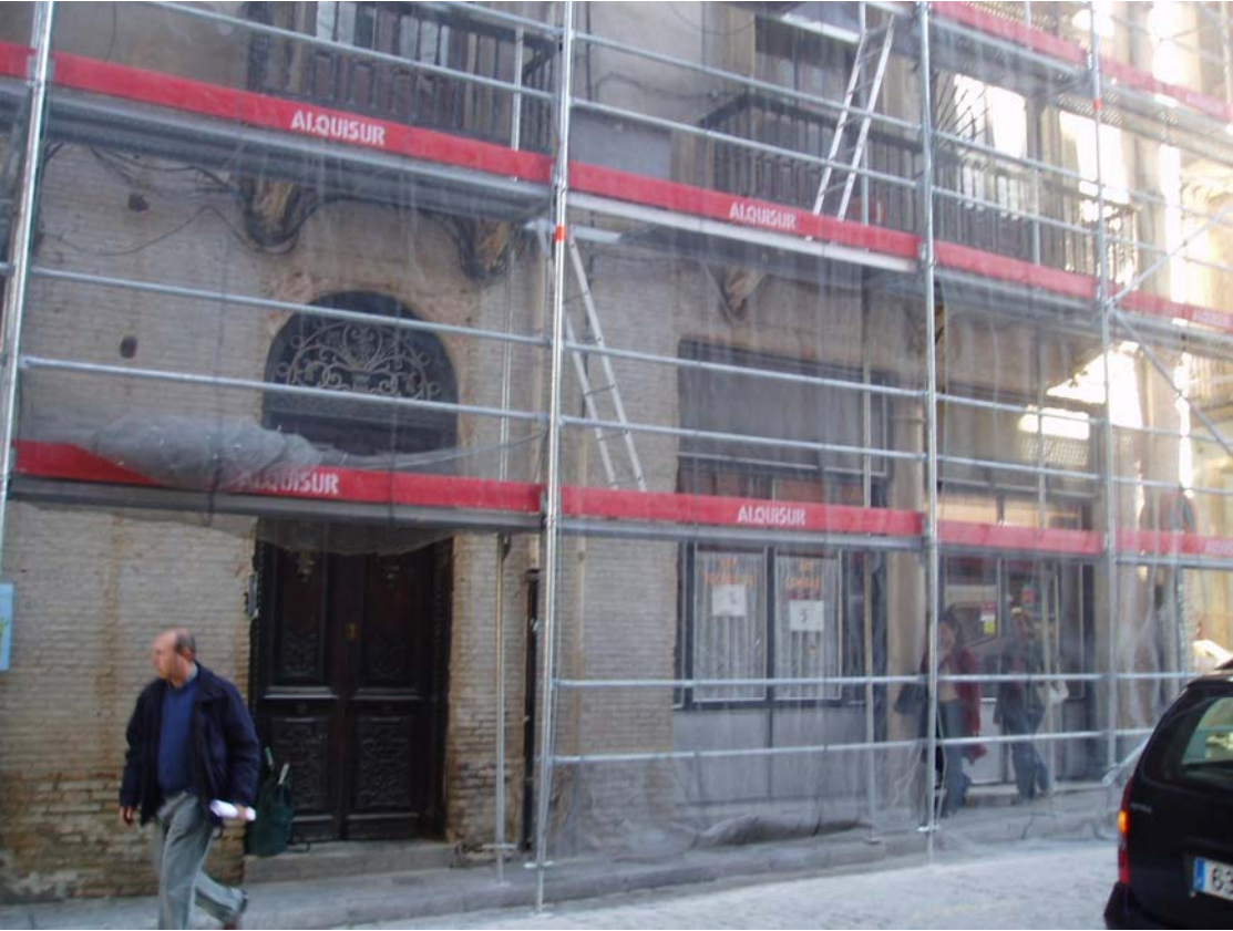
Edificio anexo al museo, en obras, C/ Santa Escolástica
