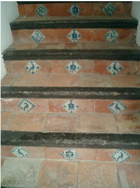
Escalera original del edificio
