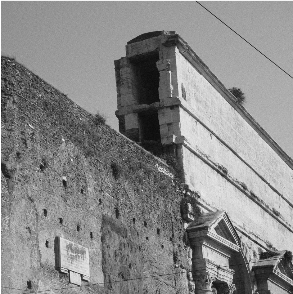
[2] Porta Maggiore , en detalle la sección donde se ven los conductos perfectamente conservados del Anio Novus (arriba) y el Aqua Claudia (abajo) sobrepuestos, en travertino (Fotografía de autoría propia)
