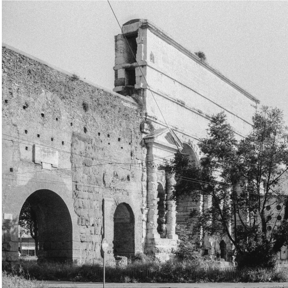
[14] Porta Maggiore , en detalle la sección de los conductos del Anio Novus y Aqua Claudia sobrepuestos (Fotografía de autoría propia)
