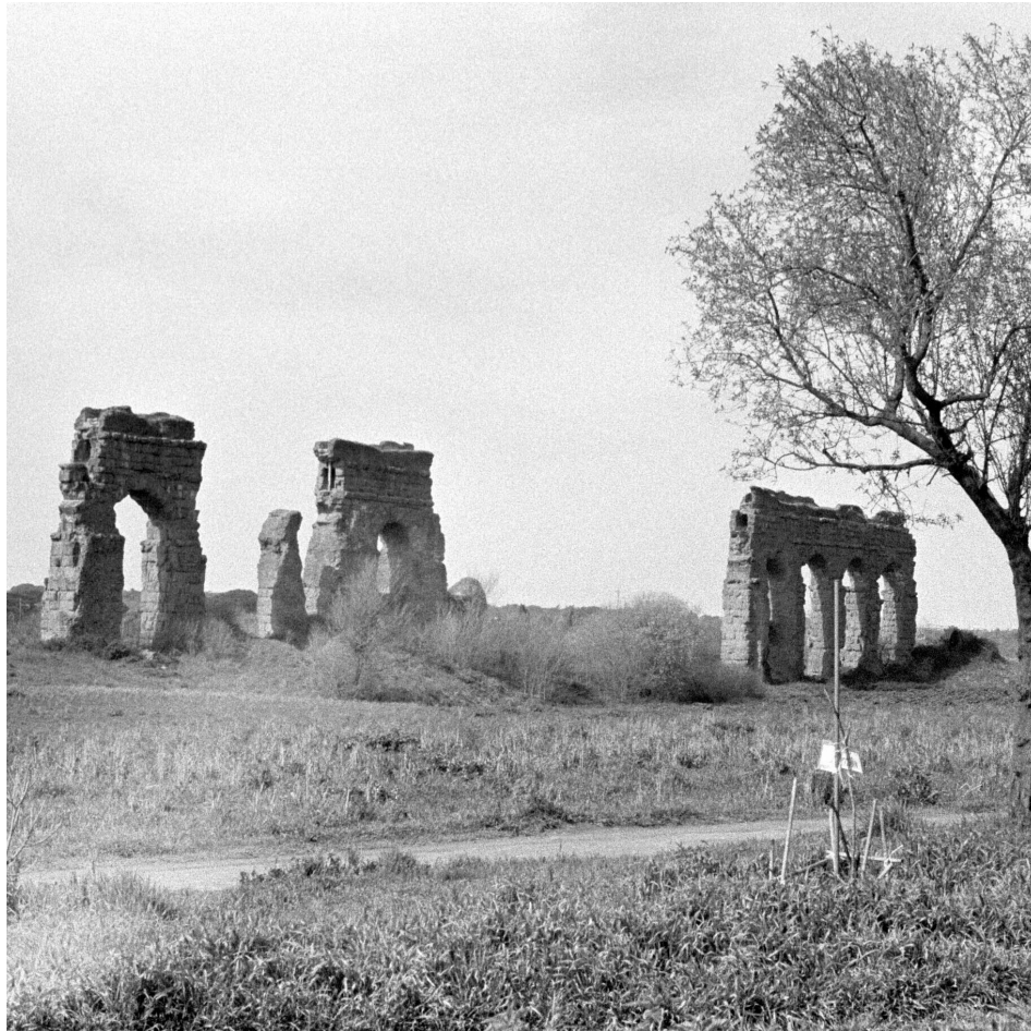
[18] Acueducto Aqua Claudia en el Parque de los Acueductos (Fotografía de autoría propia)
