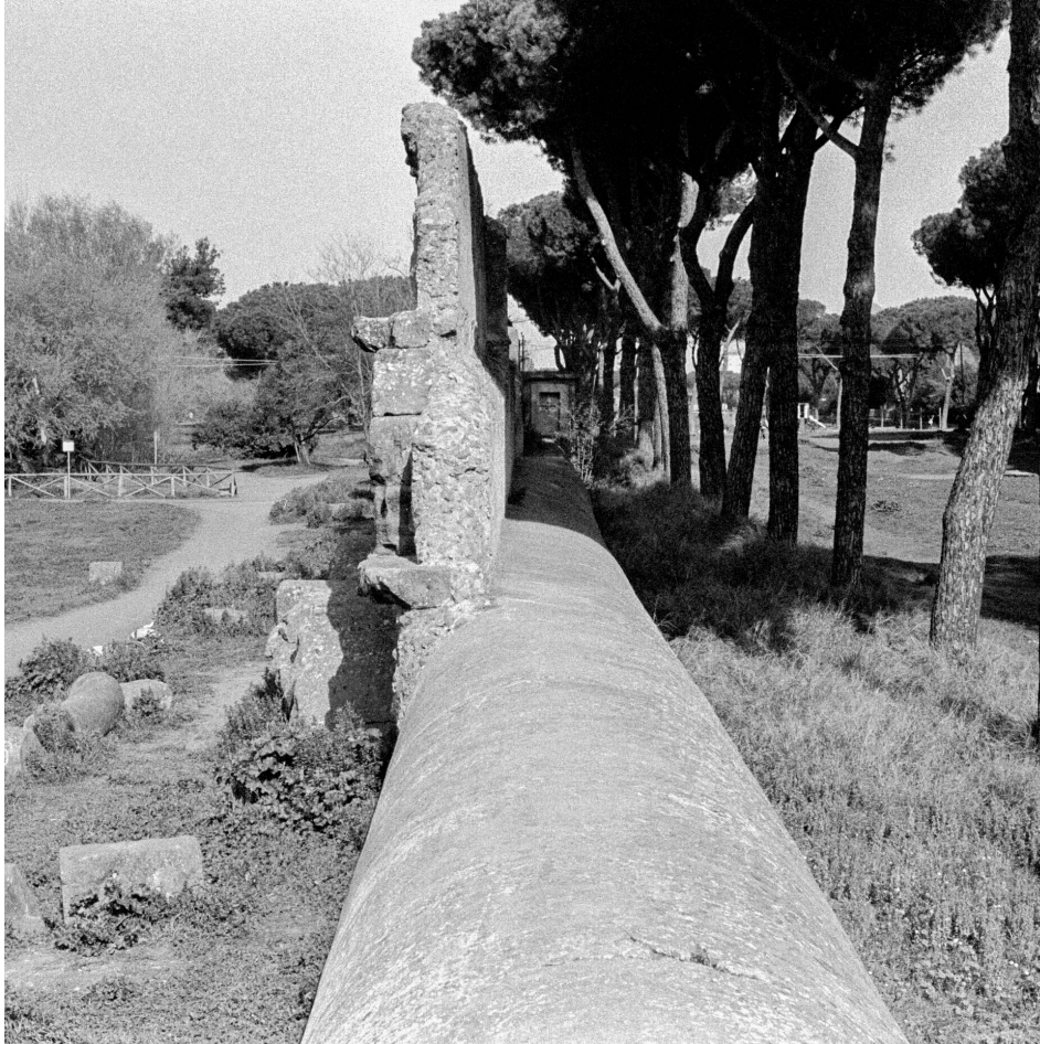
[5] Acqua Felice (1587- Sisto V), en el Parque de los Acueductos; en detalle el conducto circular a nivel de tierra, realizado en piedra, ya que gran parte del recorrido era casi subterráneo (Fotografía de autoría propia)
