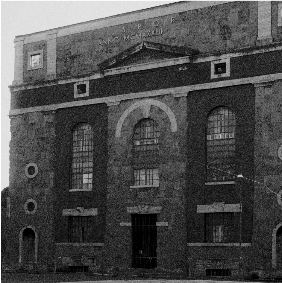
[3] Depósito de agua de la Acea (Hacienda Municipal de Electricidad y Aguas) a la altura de Porta Maggiore , palacio derivado de la domus romana construida en el siglo 3 d.C. en el lugar (Fotografía de autoría propia)
