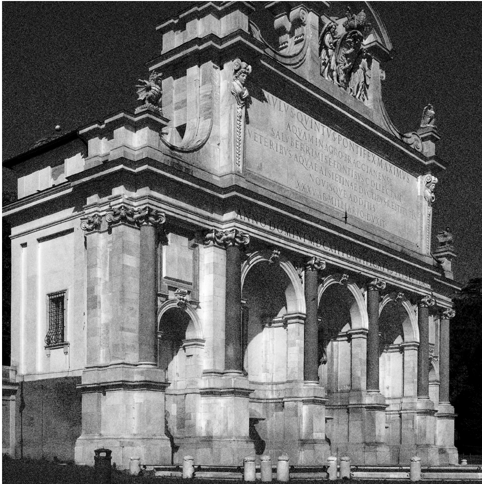
[9] Fontanone del Gianicolo (1612 - G. Fontana y F. Ponzio), "muestra" del Acqua Paola ; se ve cómo la fachada tardo-renacentista se adosa al edificio posterior que alberga la maquinaria (Fotografía de autoría propia)
