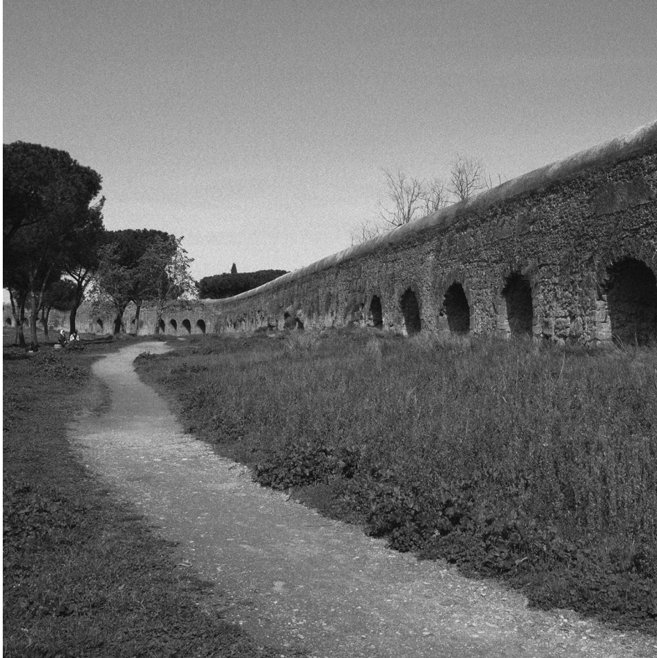
[4] Aq̄ua Felice (1587- Sisto V), en el Parque de los Acueductos; integrado con los restos del Aqua Marcia (144 a.C), se observa la altura baja y la t cnica constructiva m s moderna (Fotograf a de autor a propia)
