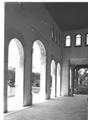
La rehabilitación de las terrazas y loggias de los extremos del museo permitirá crear espacios para el descanso y servicio de cafetería
