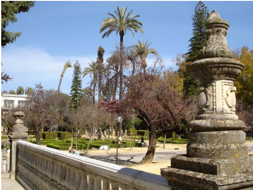
Falta del remate en terraza norte
