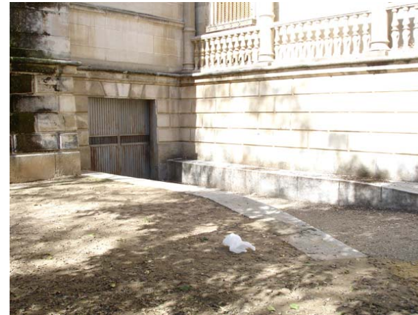
Acceso al muelle de descarga desde el exterior
