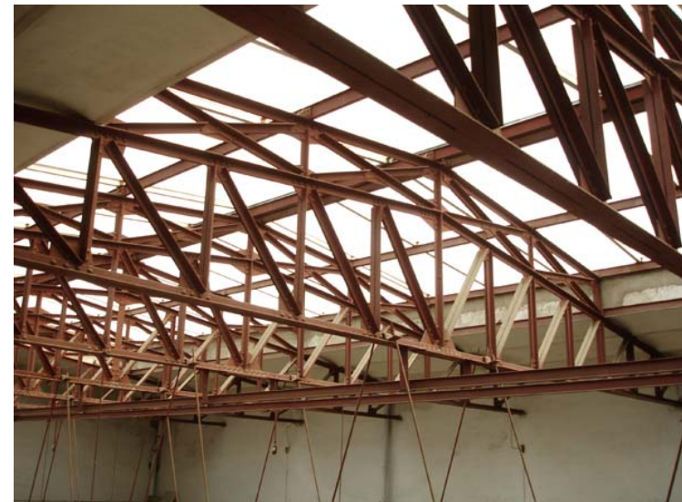
Estructura de la cubierta del óvalo (módulo central)
