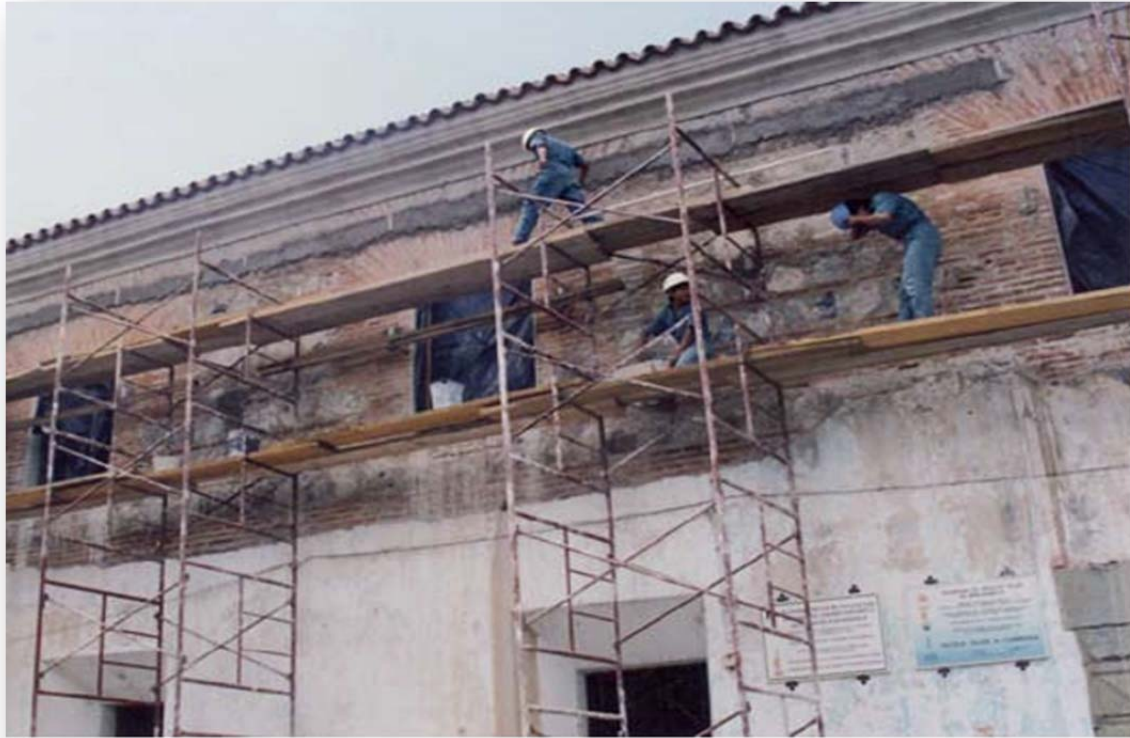
Figura 176. Proceso de restauración del claustro, área nororiental, 1992 - 1994
