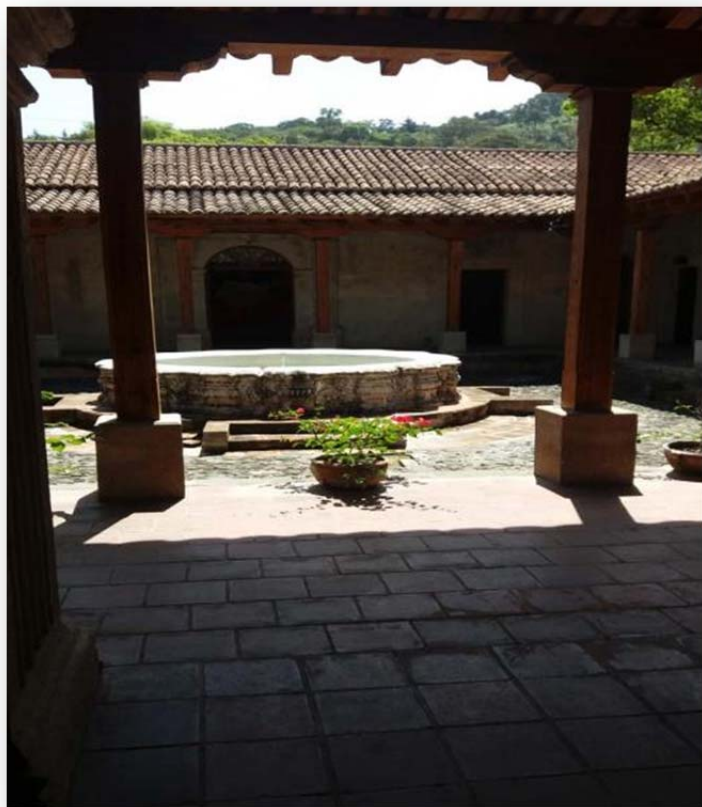
Figura 167. Restauración Convento Sor Juana
