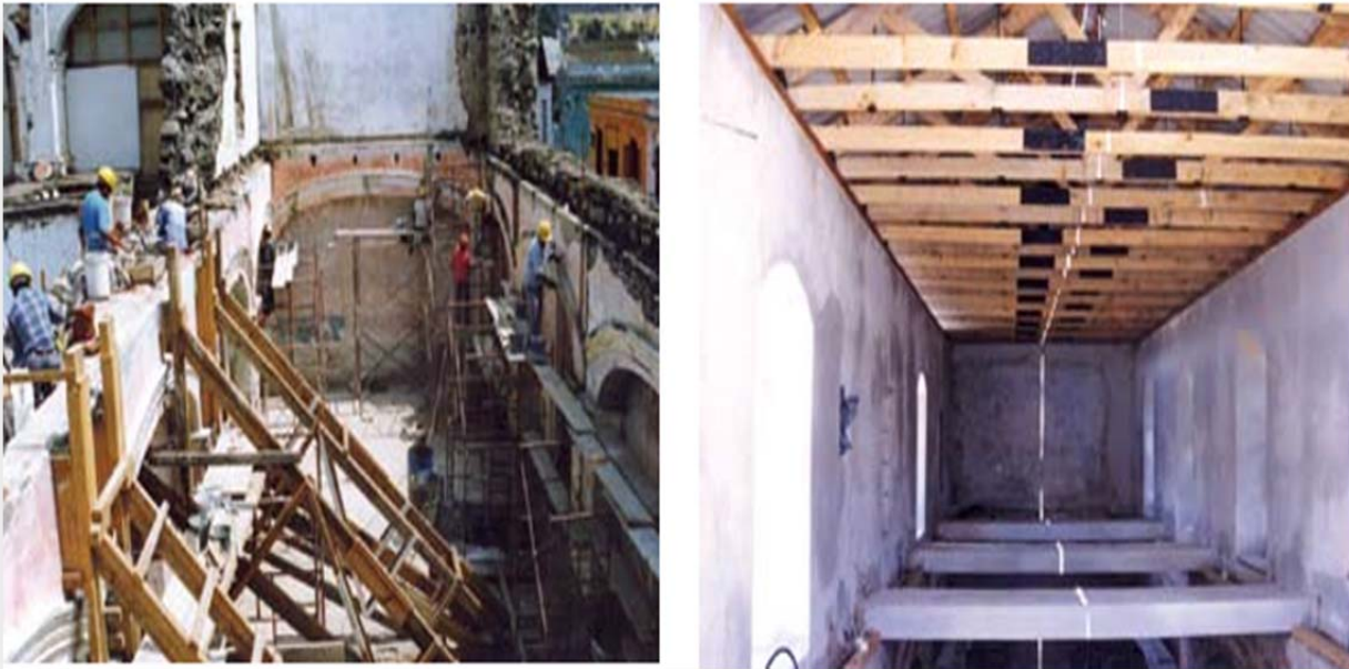
Figura 178. Labores de restauración del claustro suroriental 1998 - 2002
