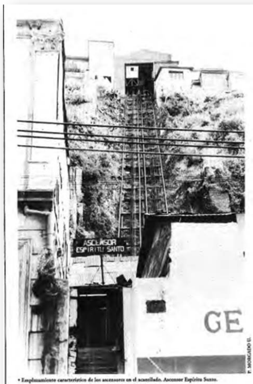
Figura 34. Ascensores de Valparaíso
