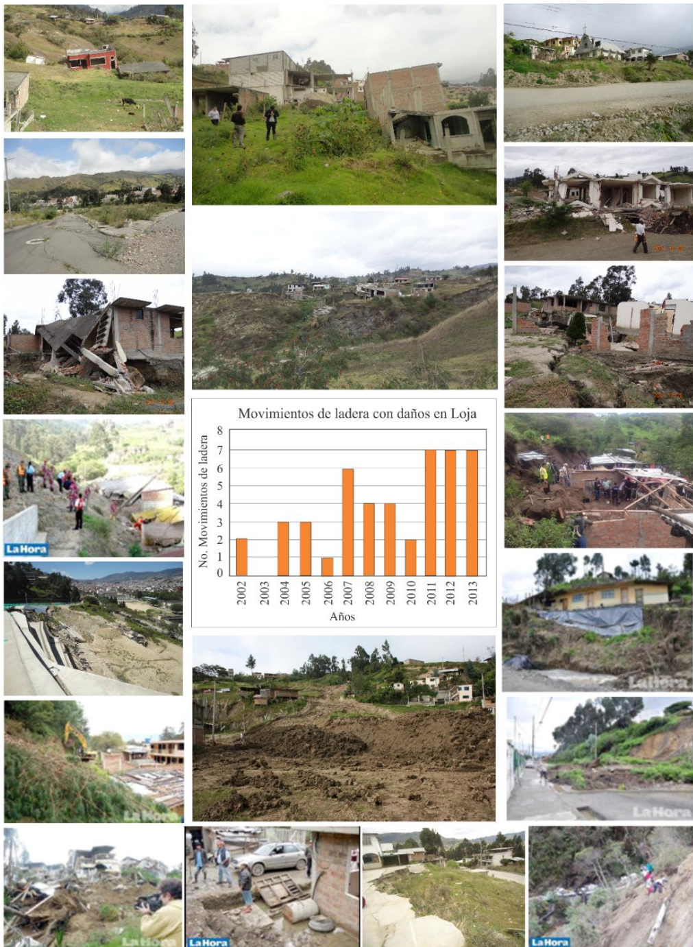
Figura 18. Daños ocasionados por los movimientos de ladera en la ciudad de Loja (Fuente: Diario “La Hora” y el autor).
