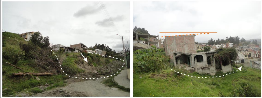
Figura 24. Movimiento de ladera clasificado como Deslizamiento rotacional
