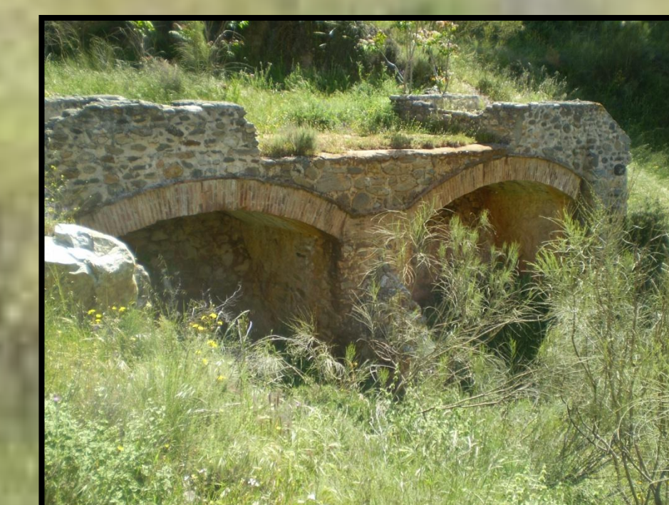
Arriba y derecha imágenes de las instalaciones de la mina y canalizaciones de los franceses.
