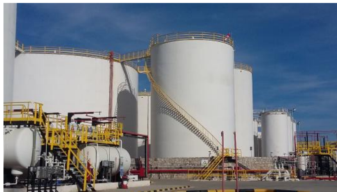
Figura 7. Vista de los depósitos de almacenamiento de las instalaciones de CLH en Motril (Granada).
