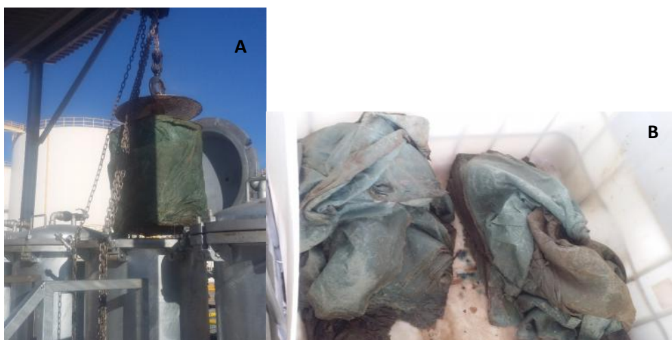
Figura 26. Extracción del material absorbente (A). Fase de biorremediación (B). Planta Piloto en instalaciones de CLH en Motril (Granada).
