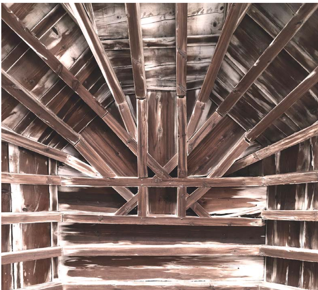
Figura 53. Detalle de la armadura.
