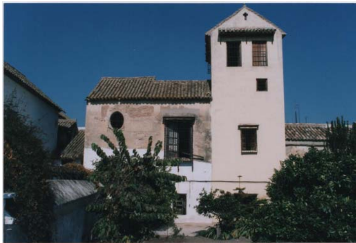
Figura 210. Fachada posterior palacete barroco.
