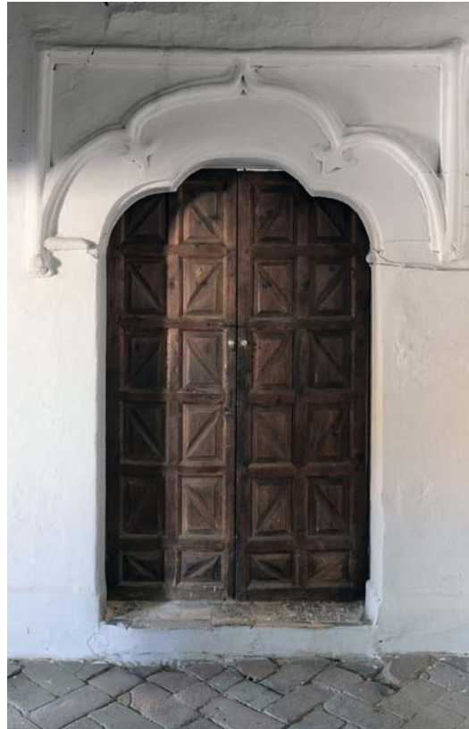
Figura 47. Puerta de acceso al coro alto.
