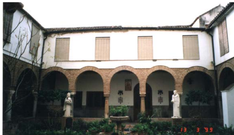
Figura 97. Fachada sur (año 1999).
