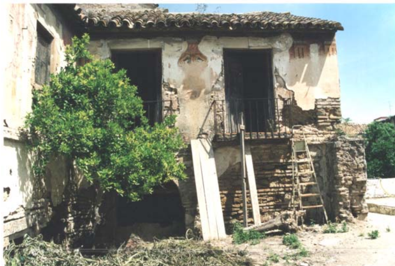
Figura 124. Fachada norte de la casa barroca (1.999).
