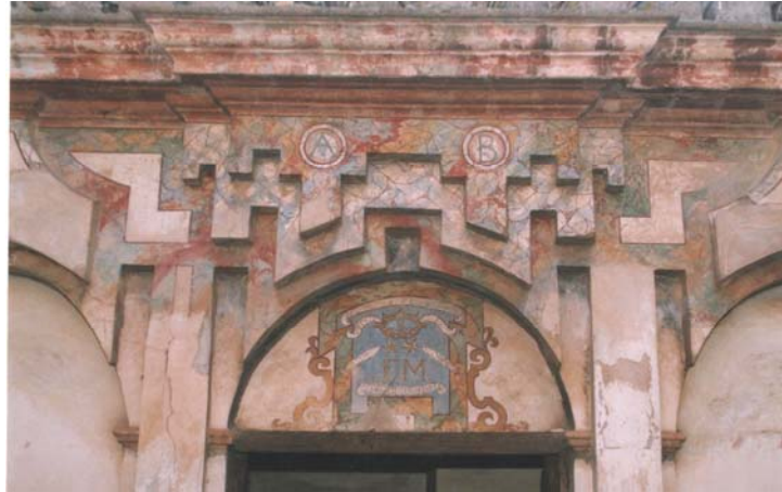
Figura 148. Detalle de calle central de la fachada este, planta alta.
