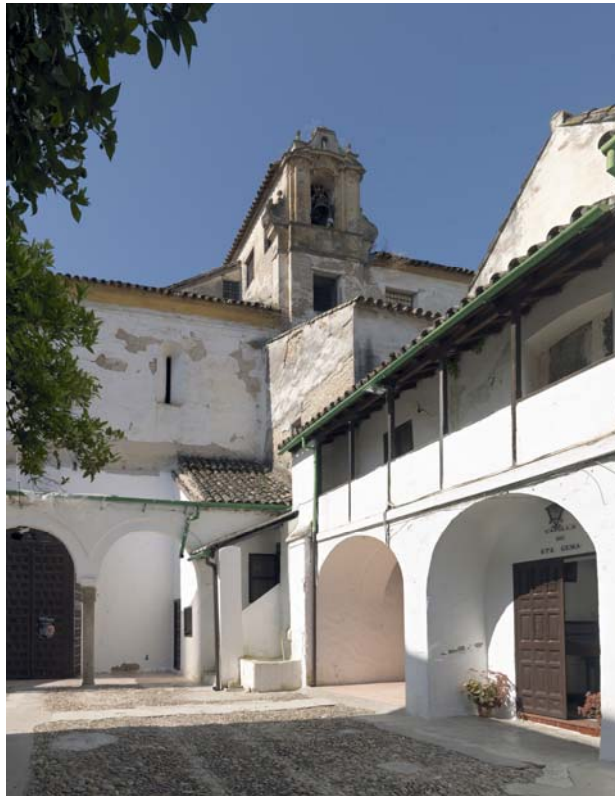
Figura 12. Segundo tramo de fachada.
