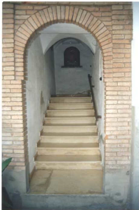
Figura 92. Escalera principal de acceso a planta alta (1.999).
