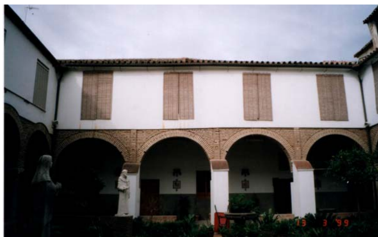
Figura 104. Fachada oeste (año 1999).
