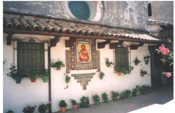
Figura 72. Detalle de la galería y altar de la fachada este.
