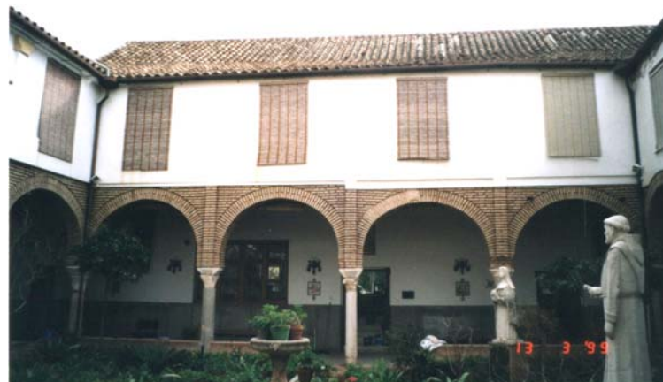
Figura 94. Fachada este (año 1999).
