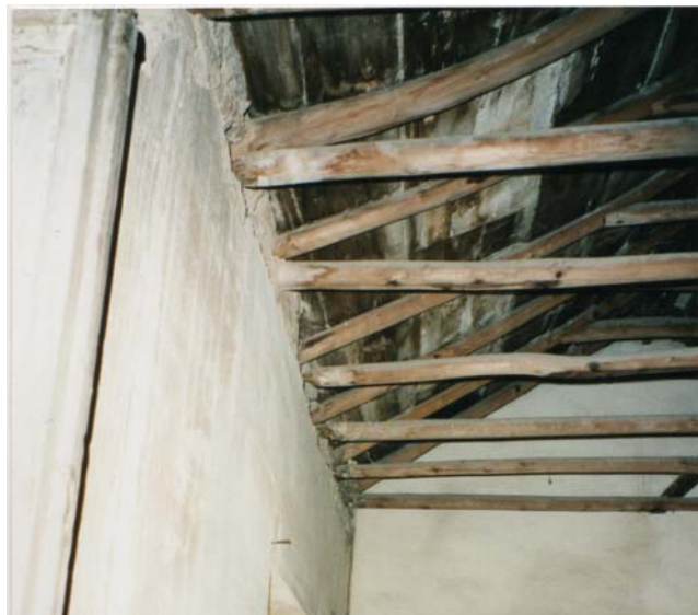
Figura 200. Imagen interior de la fachada hacia calle Valderrama.
