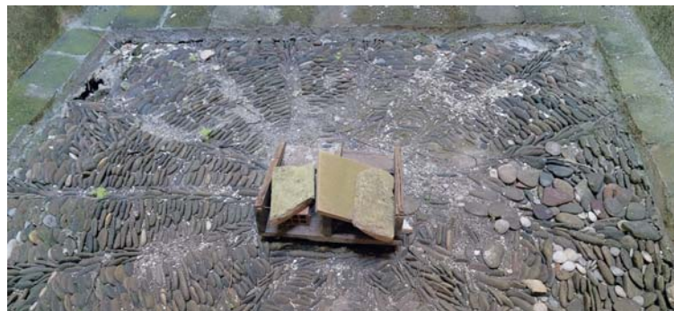
Figura 166. Detalle del pavimento.
