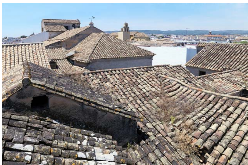
Figura 174. Vistas desde el mirador. Cubiertas del templo.
