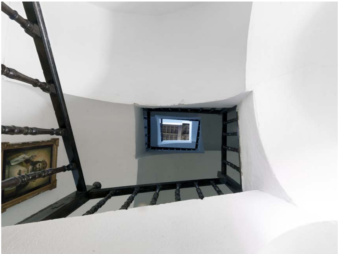
Figura 46. Vista del ojo de la escalera.
