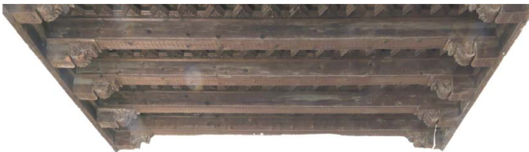
Figura 43. Detalles del artesanado del techo.
