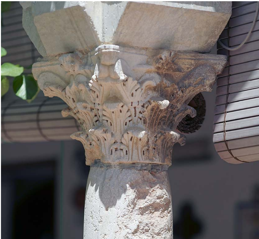
Figura 179. Galería norte. Capitel nº 6.
