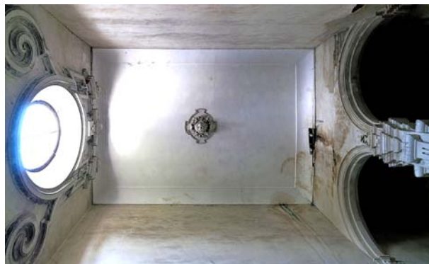
Figura 169. Detalle de la bóveda de la escalera principal.
