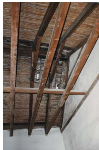
Figura 205. Estado de cubierta recayente a calle Valderrama.
