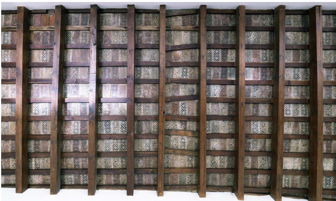
Figura 82. Detalle de la cubrición de la galería de planta baja.
