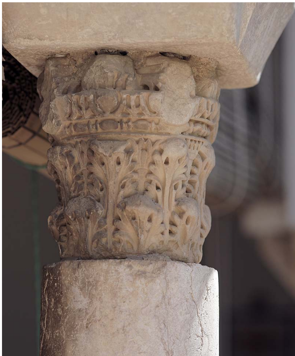
Figura 187. Galería norte. Capitel nº 8.
