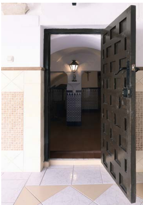
Figura 20. Puerta de acceso desde el claustro.
