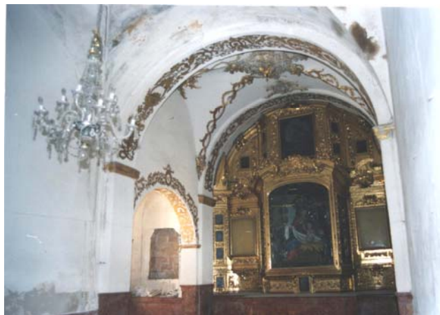
Figura 117. Vista interior de la Capilla de Ntra. Sra. de Belén (1.999).
