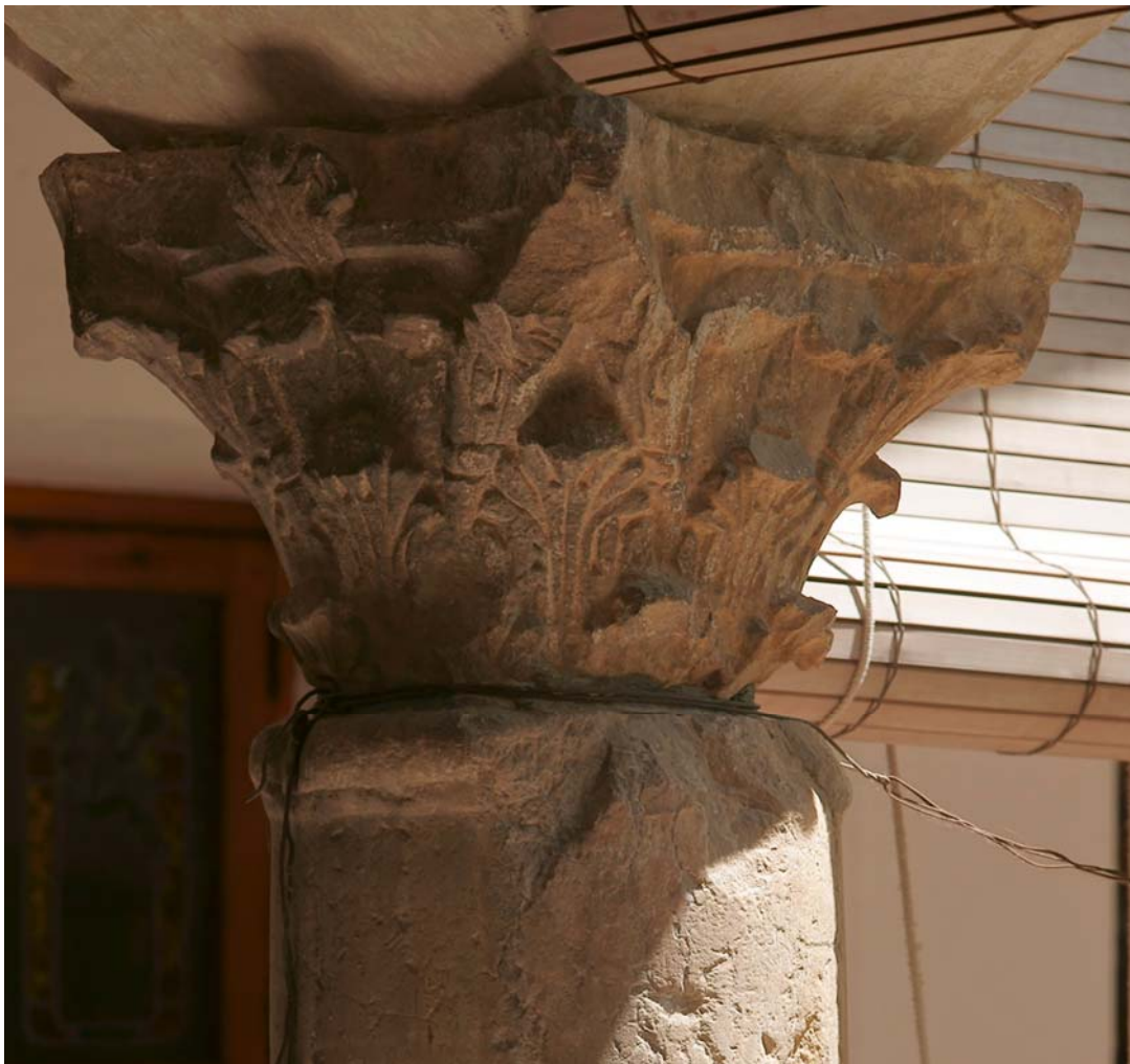
Figura 178. Esquina galerías norte-oeste. Capitel nº 5.
