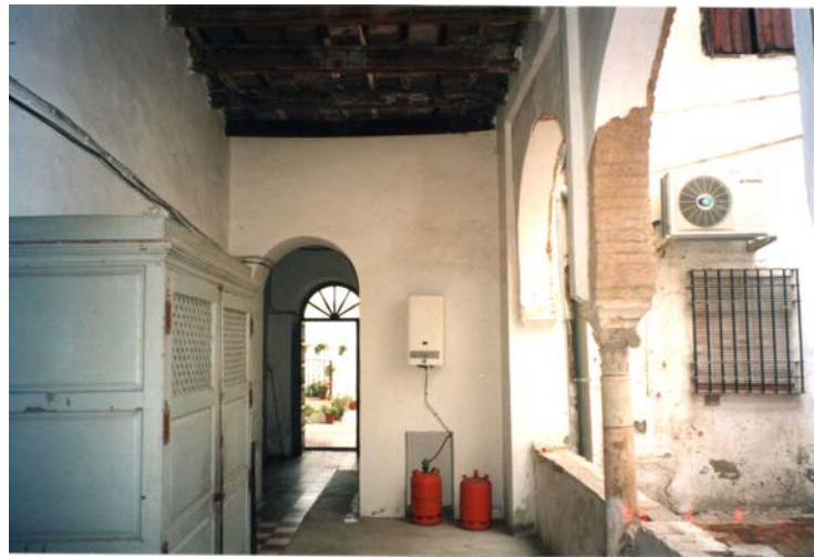
Figura 111. Galería norte-sur del patio de la Piscina (año 1999).
