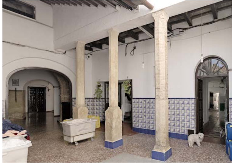
Figura 74. Galería de la fachada sur.
