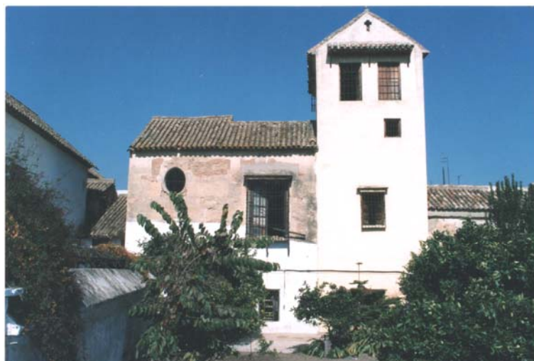
Figura 136. Fachada sur recayente al huerto.
