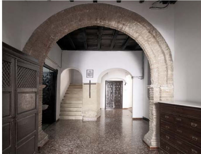
Figura 78. Detalle del arco de medio punto.
