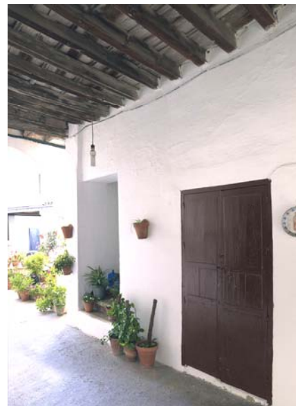
Figura 68. Galería norte de acceso al patio.
