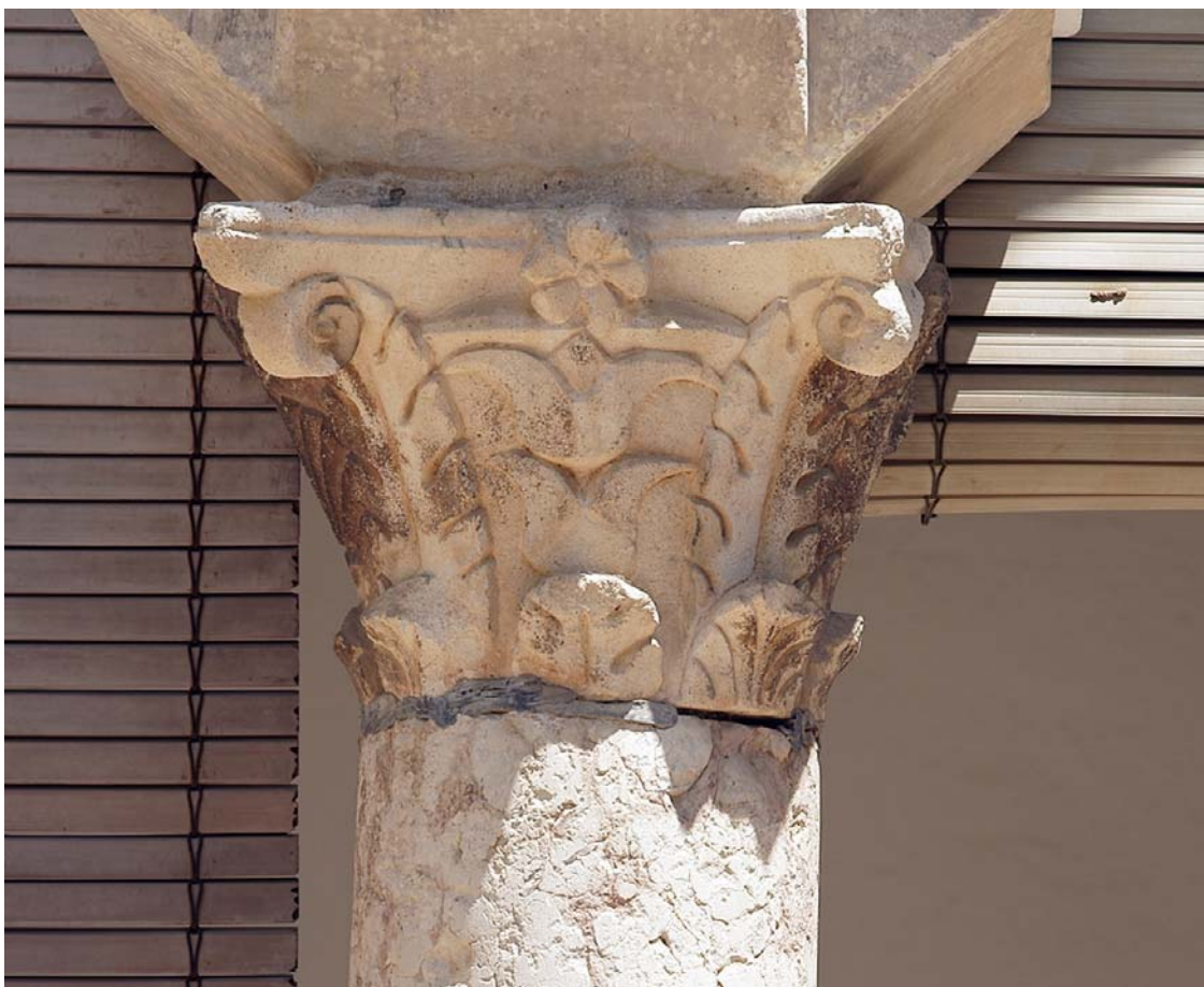
Figura 180. Galería norte. Capitel nº 7.
