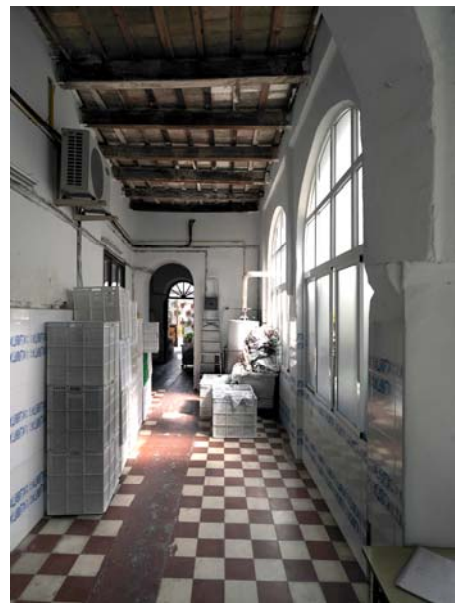
Figura 113. Galería norte-sur (estado actual).
