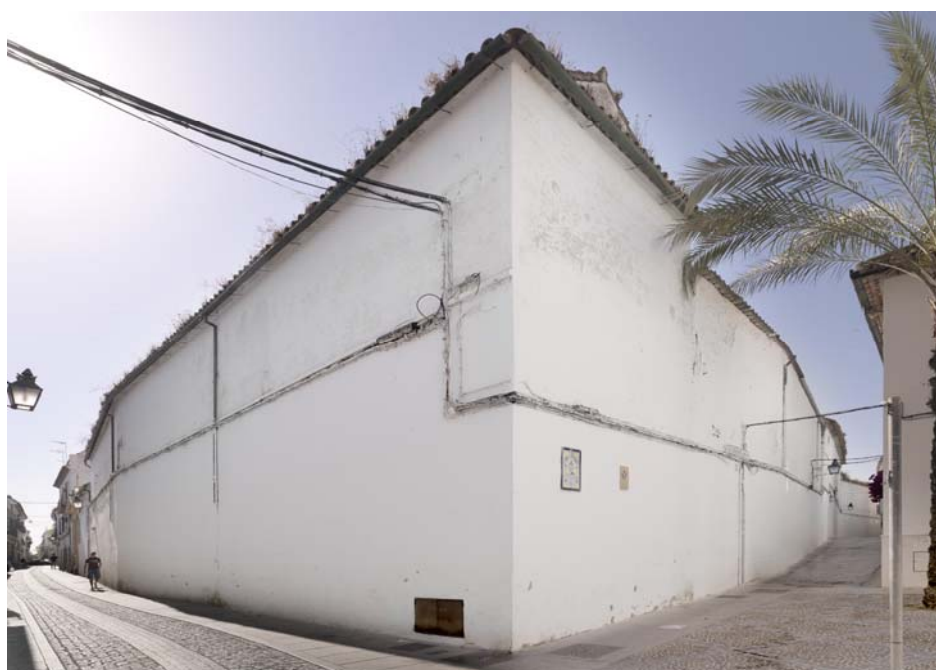
Figura 4. Esquina calle Agustín Moreno con calle Valderrama.
