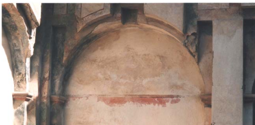
Figura 156. Detalle del estuco de la fachada norte.
