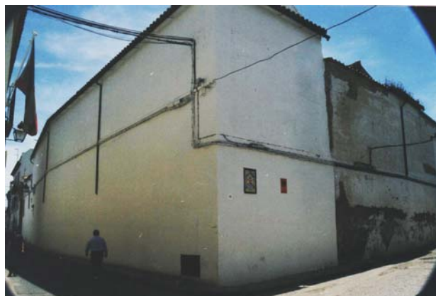
Figura 199. Esquina encuentro calle Agustín Moreno y Valderrama.
