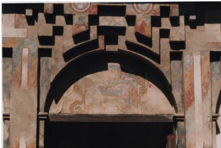
Figura 160. Detalle de calle central de la fachada oeste, planta alta.
