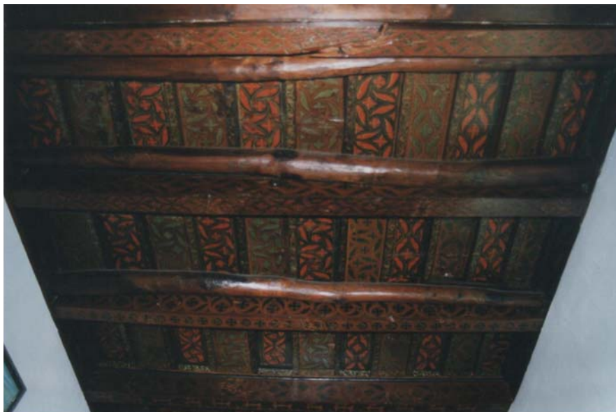
Figura 106. Detalle del forjado gótico de la Abadía.
