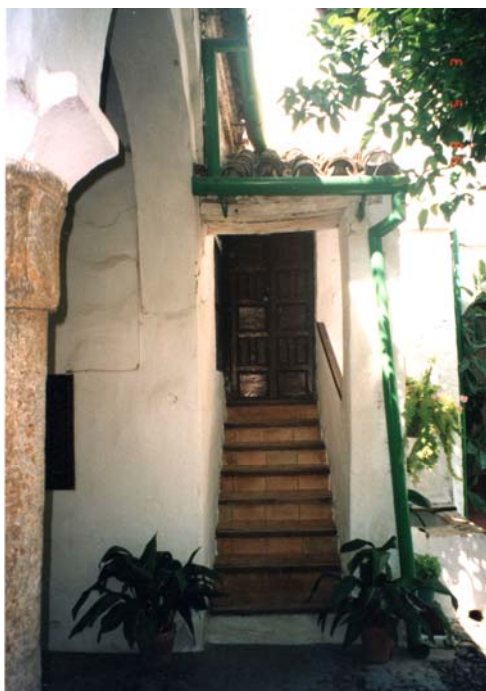
Figura 17. Escalera del compás.
