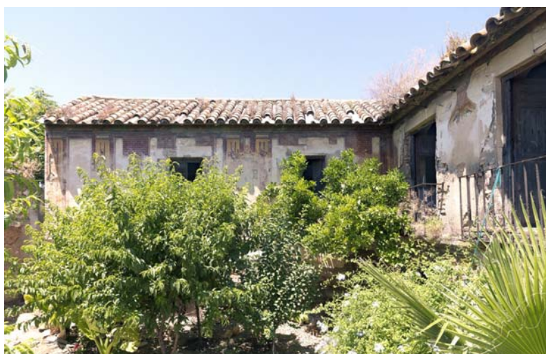
Figura 126. Fachadas norte y oeste de casa barroca (estado actual).
