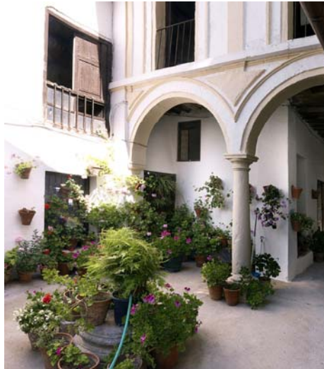
Figura 70. Detalle de la arcada de la fachada norte.
