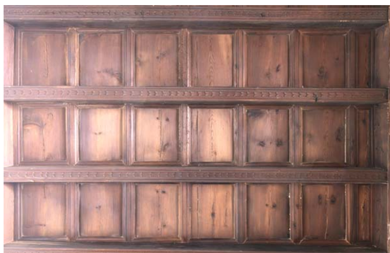
Figura 41. Detalle del artesanado del techo del acceso al coro bajo.
