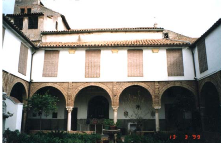
Figura 86. Fachada norte (año 1999).
