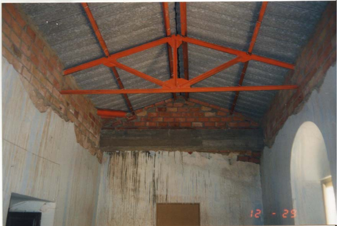
Figura 208. Actuación de emergencia en techumbre de la casa Mudéjar.
