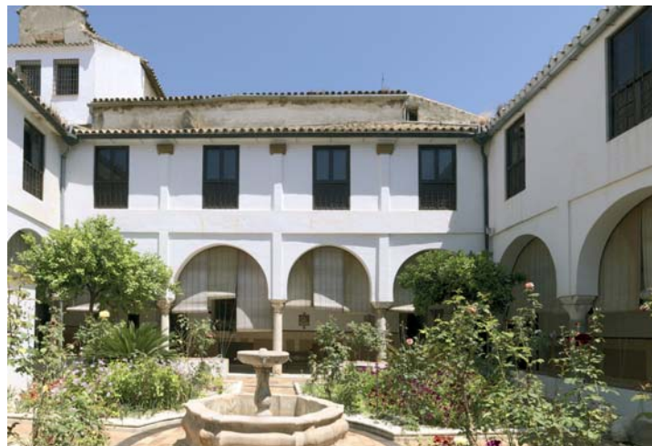
Figura 87. Fachada norte (estado actual).
