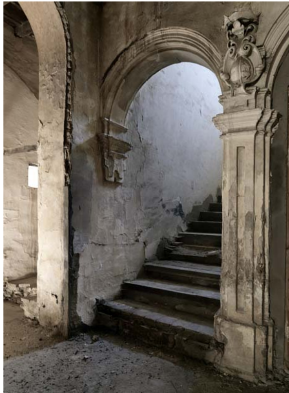
Figura 167. Arranque en planta baja de la escalera principal.
