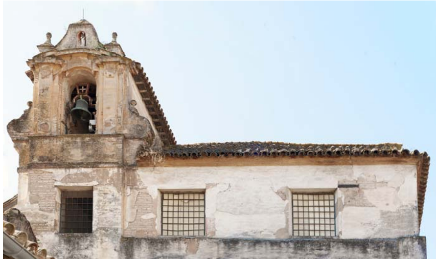
Figura 56. Vista exterior del campanario.
