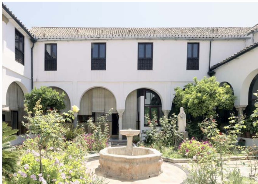
Figura 95. Fachada este (estado actual).
