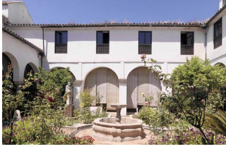
Figura 105. Fachada oeste (estado actual).
