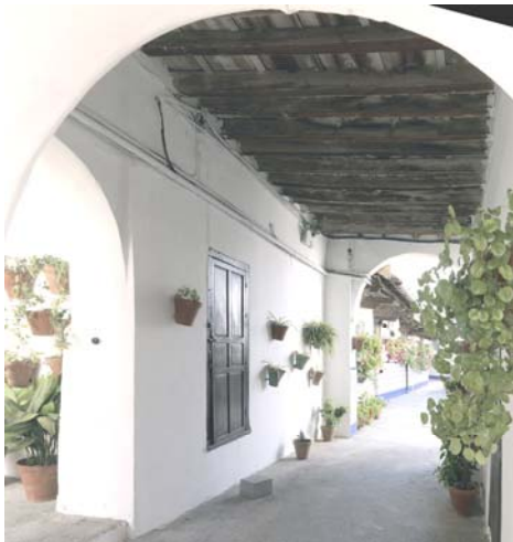
Figura 67. Galería norte de acceso al patio.
