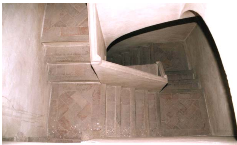
Figura 172. Escalera de acceso al mirador.
