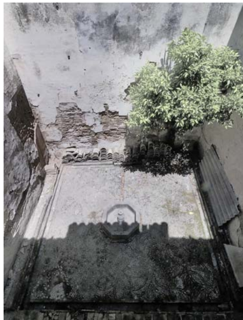
Figura 162. Vista del patio-jardín.
