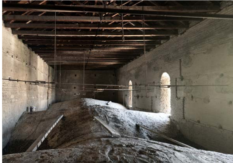
Figura 26. Bóvedas de la nave.
