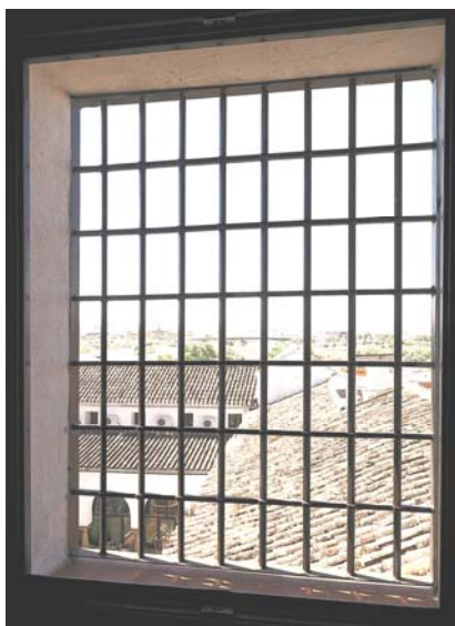
Figura 57. Ventana lateral del campanario.
