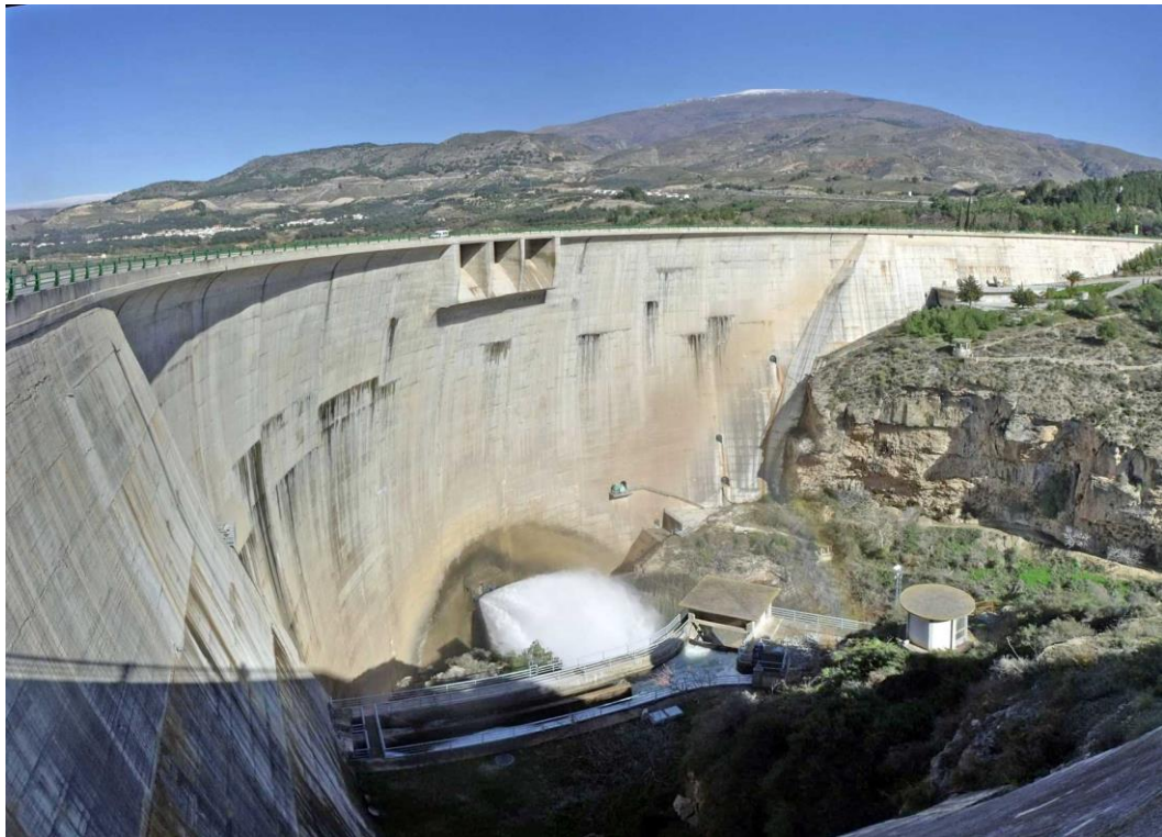
FIGURA 5. Presa de Béznar
