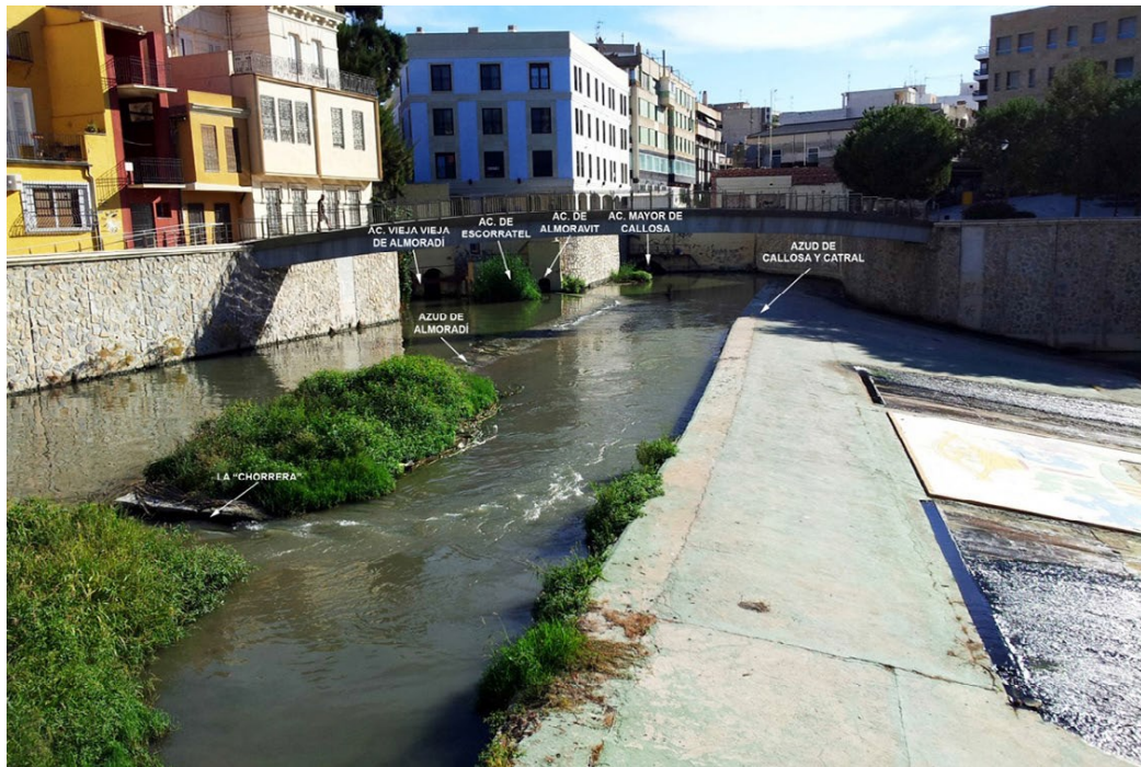
Fig. 3. Vista de los azudes de Almoradí, y de Callosa y Catral, con las tomas de las acequias ubicadas en ellos (Fuente: Trapote et alii , 151, fig. 14, fotografía de los autores)
