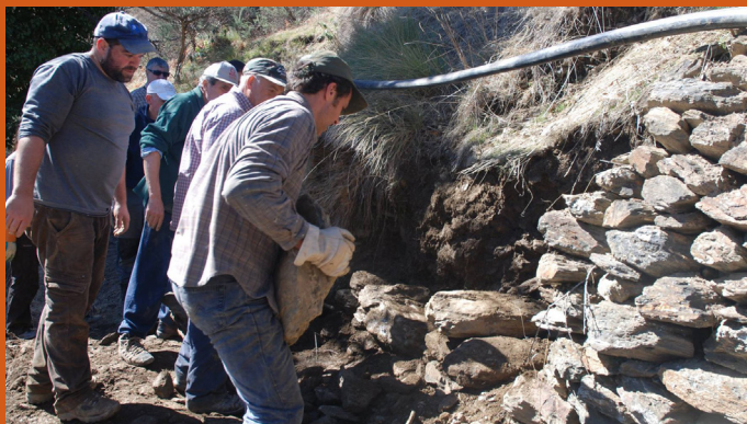
Fig.24 Construcción de un balate. Fuente: Lara Delgado
