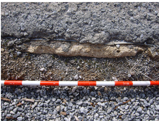
Foto. Poza de evaporación (vacía) en el que se aprecia la capa de hormigón y el plástico sobre el muro antiguo
