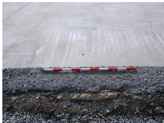
Foto. Poza de evaporación (vacía) en el que se aprecia la capa de hormigón y el plástico sobre el muro antiguo
