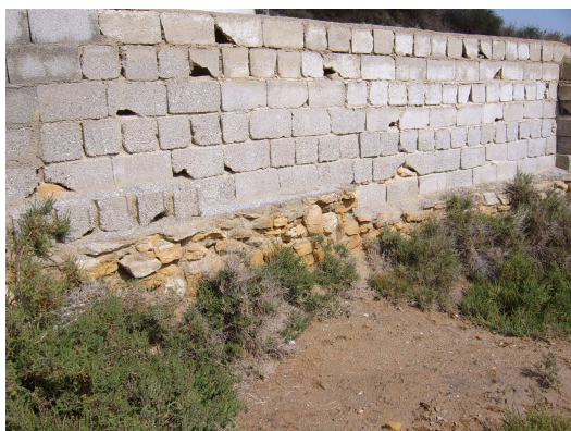
Foto. Cuatro de los numerosos muros recrecidos con materiales contemporáneos
