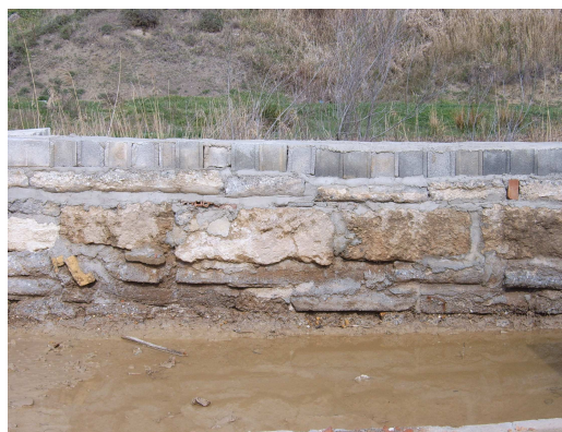
Foto. Cuatro de los numerosos muros recrecidos con materiales contemporáneos
