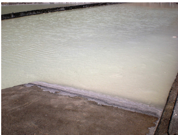
Foto. En la esquina inferior izquierda se puede observar una de las rampas que se realizaron en algunas piletas el acceso de los dumpers a las mismas
