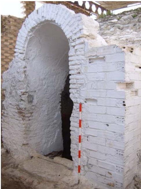
Foto. Detalle de la consolidación de uno de los arcos que da acceso a una sala de baño
