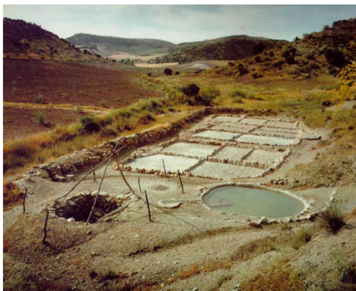
Foto. Salinas de Montejícar. Se observa el pozo, el calentador de forma circular y los cristalizadores
