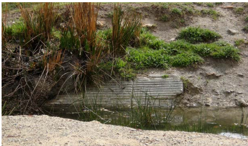
Foto. Detalle de las pilas de lavar
