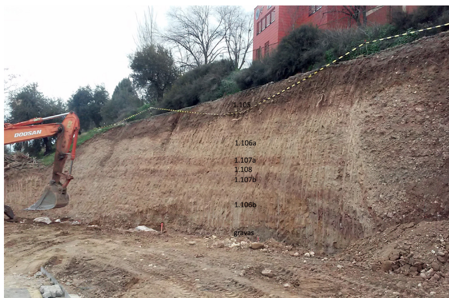
Figura 4. Desmote de una ladera arcillosa en el sector NE del campus, donde se localizó el punto de interés arqueológico 1.100 (P.I. 1.100, fig. 3). Se aprecia en la secuencia el estrato 1.106a donde se documentó un posible corte de cantería.
