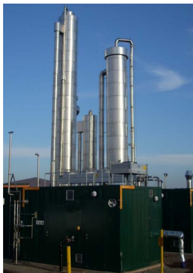
Figura 1.8. Planta de refinamiento de biogás por aminas líquidas en Könnern (Alemania).
