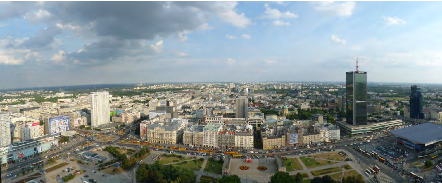
_Vista aérea del tramo completo de Jerolimskie junto al Palacio de la Cultura
