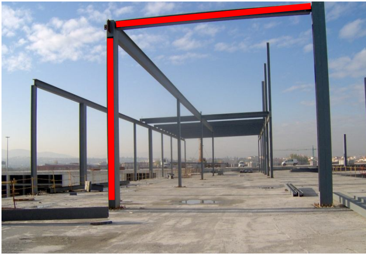
Estructura metálica articulada
