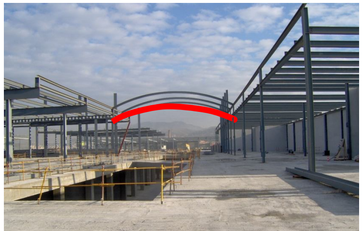
Estructura metálica articulada
