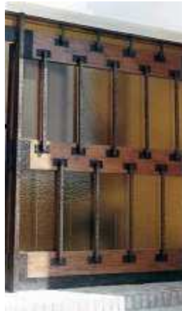
Ilustración 72: Puerta Entrada Viviendas Sociales en la Barriada de Cartuja en Granada
