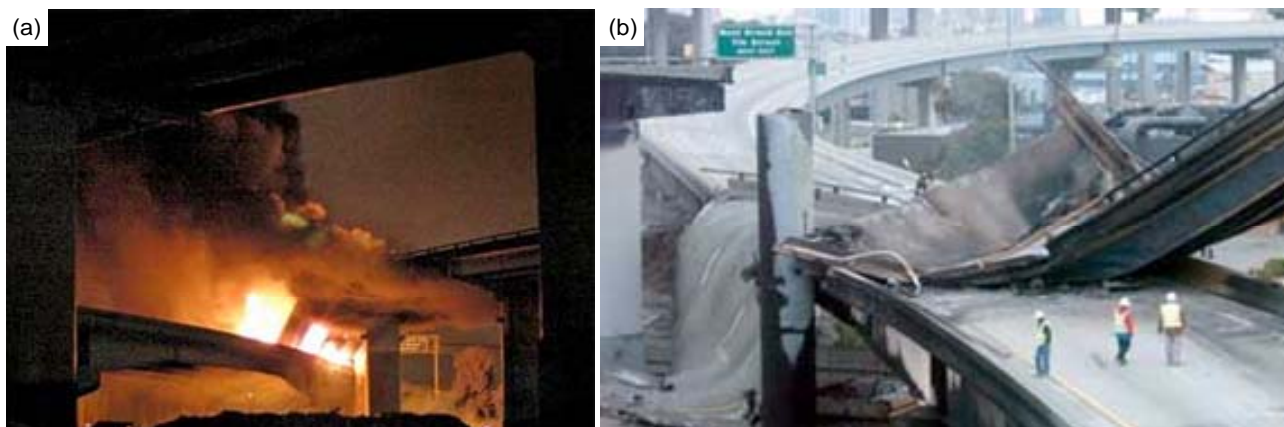
Figura 1. Colapso del Intercambiador Mc Arthur en Oakland: (a) puente bajo la acción del fuego, (b) estado en que quedó el puente tras el incendio. Fotografías: (a) Noah Berger, Associated Press, (b) Mark Constantini, San Francisco Chronicle.
