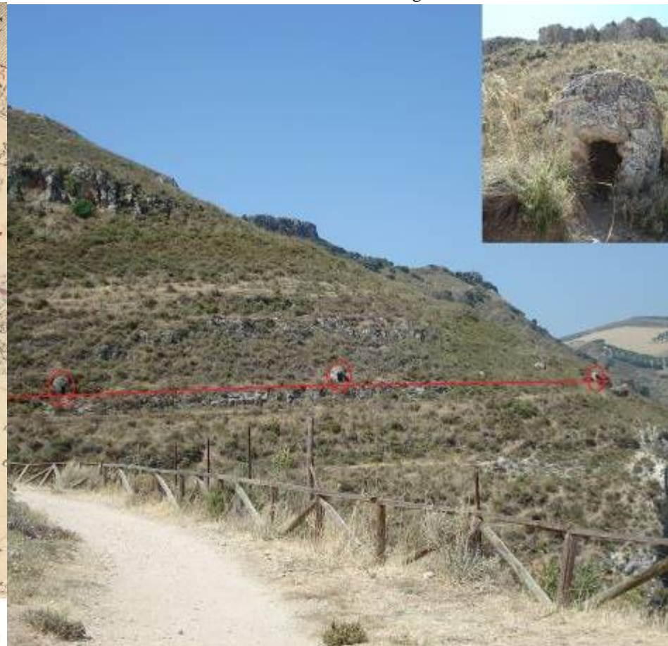
Figura 74. Arcas de abastecimiento de agua a la ciudad de Antequera y detalle de una de ellas. Imágenes del autor.
