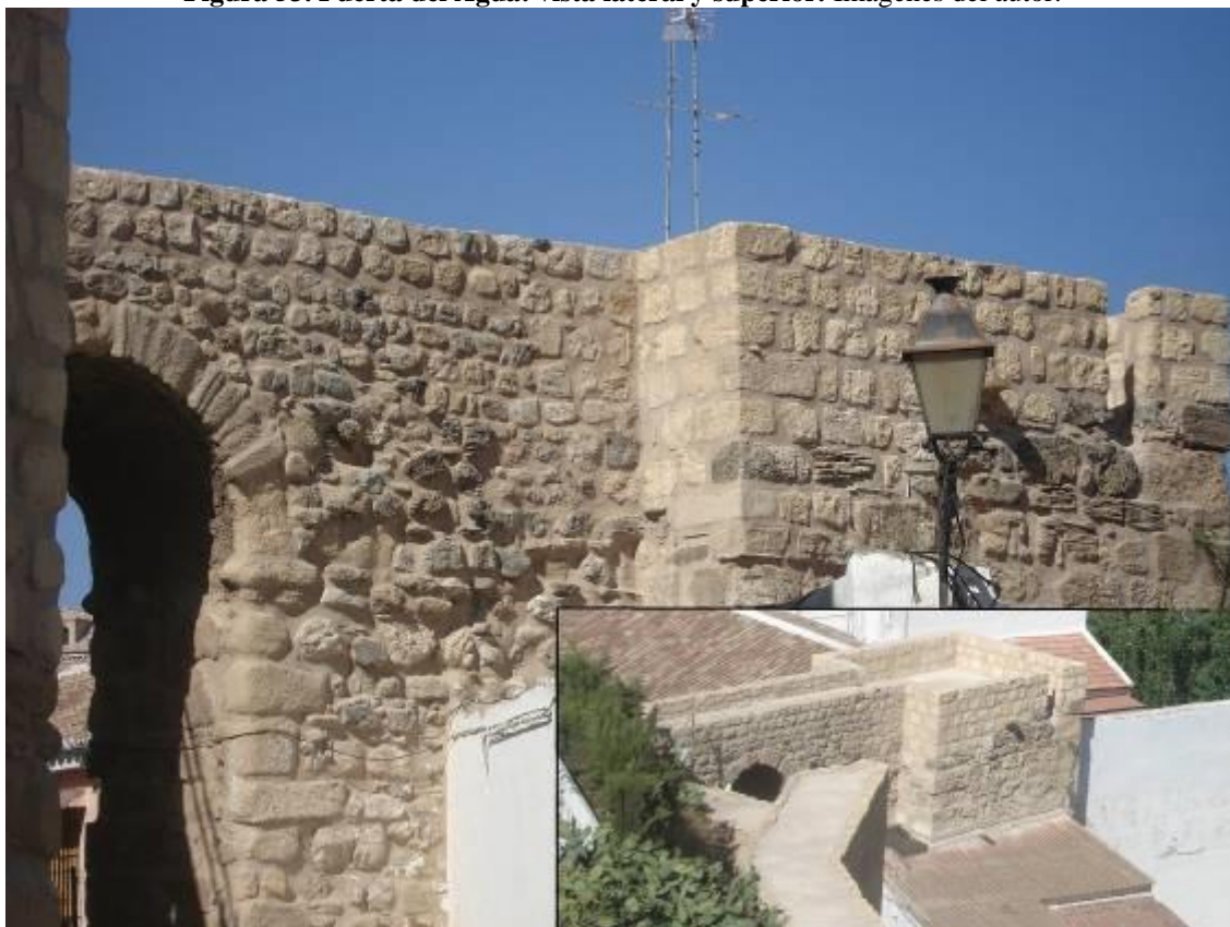
Figura 53. Puerta del Agua: vista lateral y superior. Imágenes del autor.
