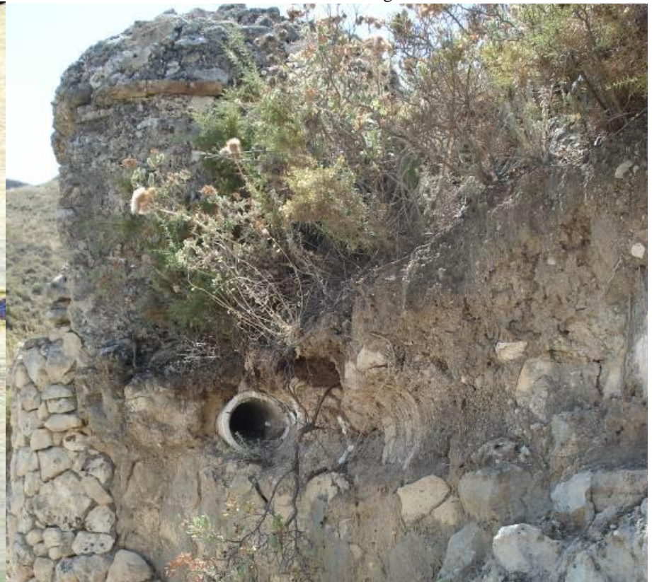
Figura 77. Arca de abastecimiento con restos de atadores de entrada al descubierto. Imagen del autor.
