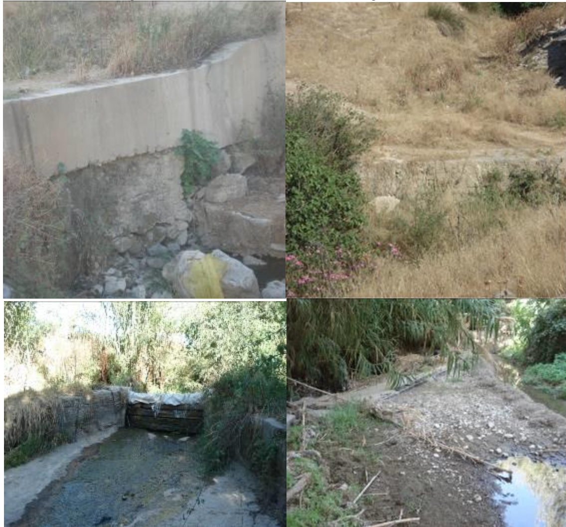
Figura 64. Presas sobre el río de la Villa. Imágenes del autor.
