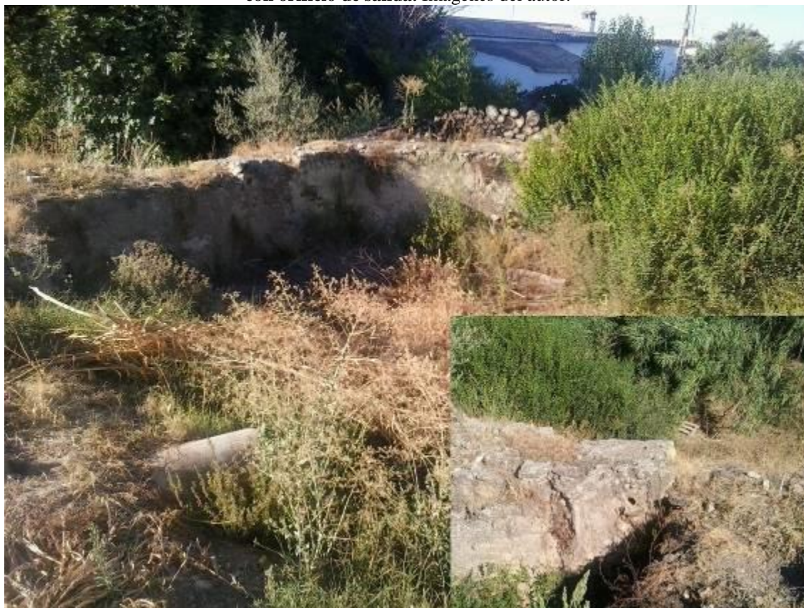
Figura 60. Alberca de la vega de Antequera relacionada con la Acequia Alta y detalle del exterior con orificio de salida. Imágenes del autor.
