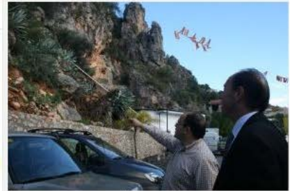
El alcalde y un vecino señalan las grandes piedras sueltas que amenazan viviendas y vehículos. :: J. M. DE HARO
