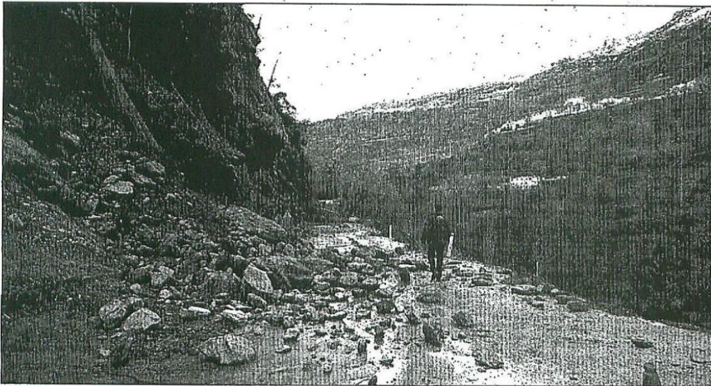
La carretera que asciende a Pampaneira, en la Alpujarra, permanece cortada por el desprendimiento de tierras y de rocas.
