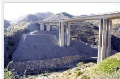
Vista del viaducto de La Alcazaba, ayer, horas antes de que se reabra al tráfico. / A. AGUILAR
