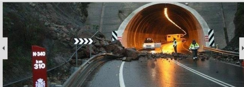
Entrada del túnel cortado. J. M. DE HARO
