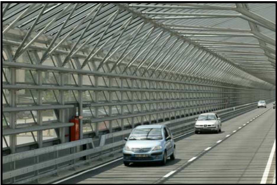
Figura 5.1: Ejemplos de cubrición de carretera para reducción de ruido. Fuente: [Alegre Marrades, 2013].
