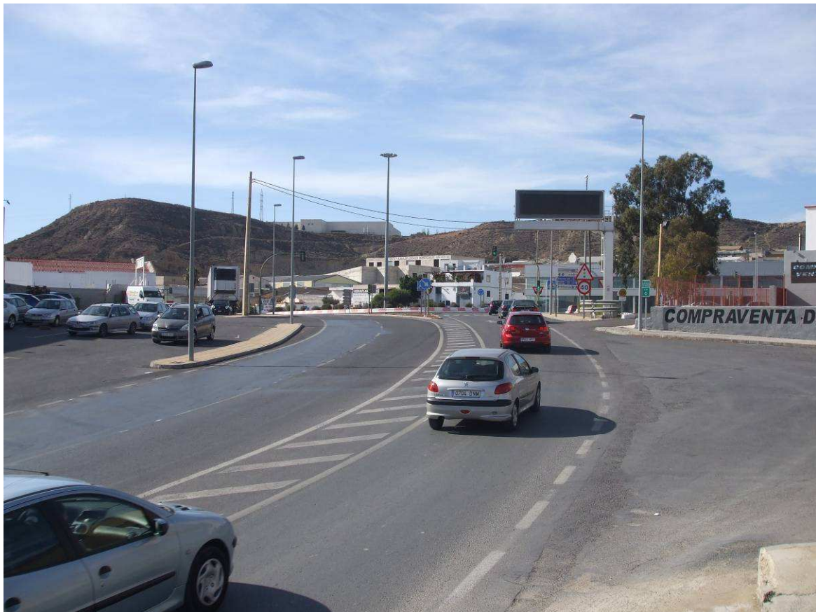
Figura 6.7: Vista del inicio del primer subtramo de la carretera A-1000. Fuente: elaboración propia.
