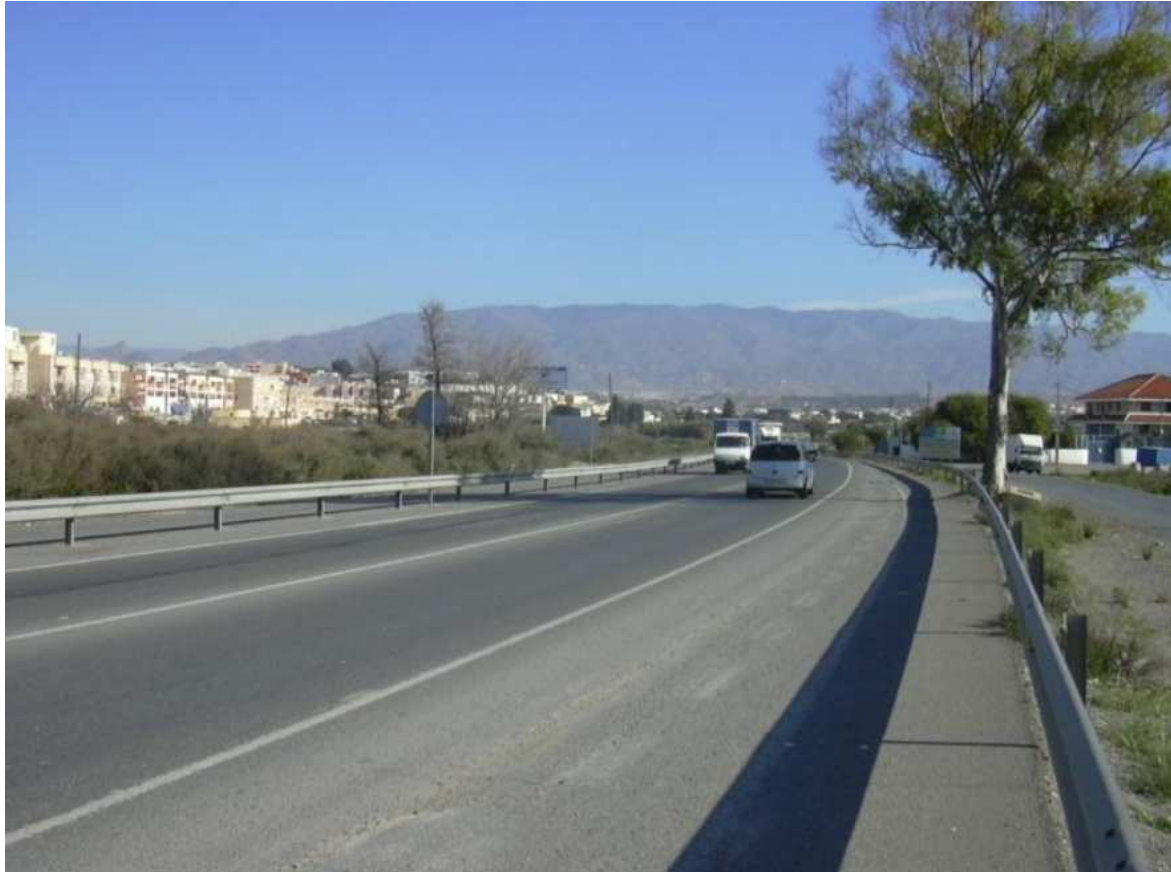
Figura 6.11: Vista del subtramo 3 de la carretera A-1000. Fuente: elaboración propia.
