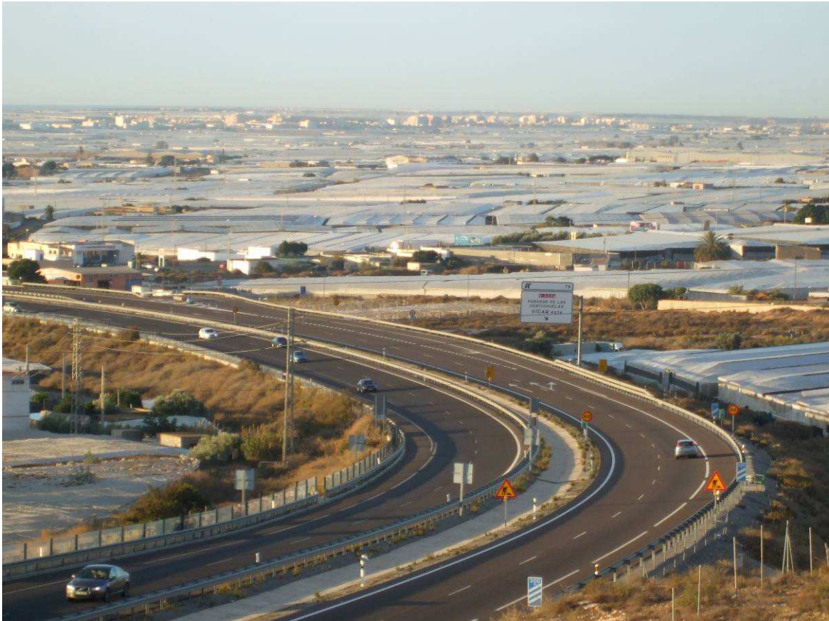
Figura 6.13: Vista del subtramo 3 de la carretera A-1051. Fuente: elaboración propia.
