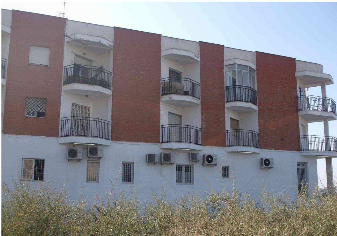
Figura 6.17: Vista de un bloque de viviendas junto al tramo de la carretera A-1051 estudiado. Fuente: elaboración propia.
