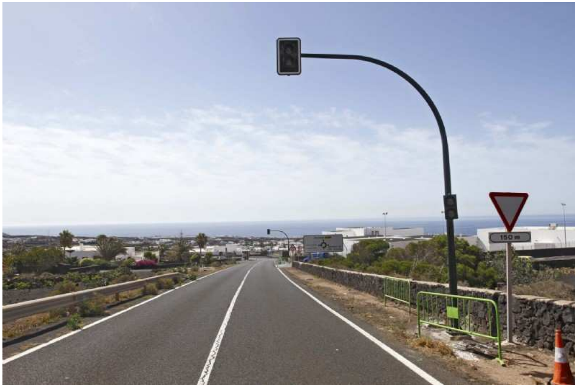
Figura 6.28: Ejemplo de grupo semafórico de preaviso y gestión del tráfico en una carretera. Fuente: elaboración propia.
