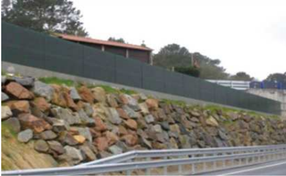
Figura 5.6: Ejemplo de barrera acústica mixta. Fuente: [COPV, 2012]
