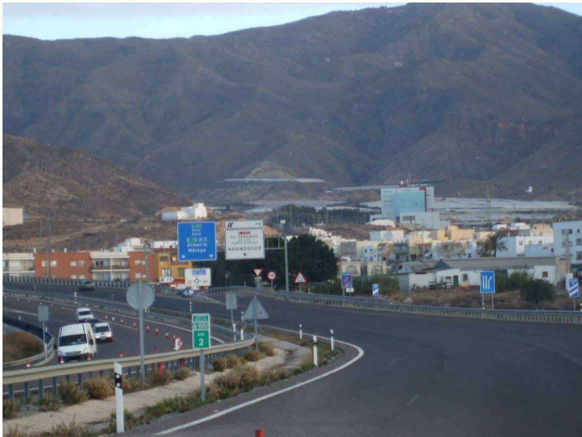
Figura 6.14: Vista del subtramo 4 de la carretera A-1051. Fuente: elaboración propia.
