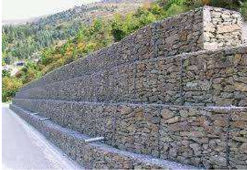
Figura 5.4: Ejemplo de muro de gaviones. Fuente: [COPV, 2012]
