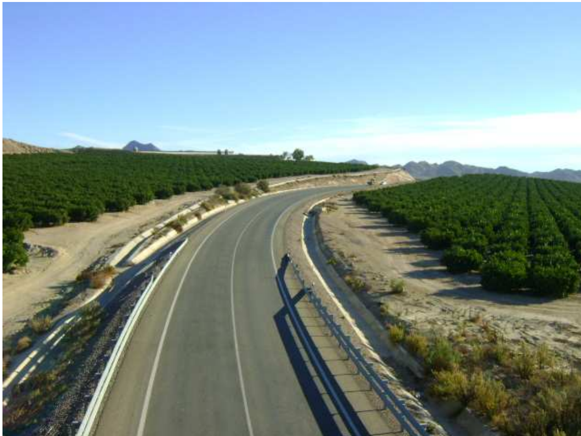
Figura 6.15: Vista del tramo de la carretera A-1201 desde la estructura del P.K. 14+150. Fuente: elaboración propia.
