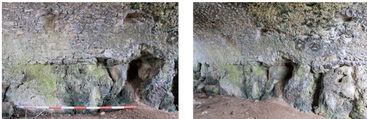
Fig. 102: Construcción del criptopórtico sobre la roca
