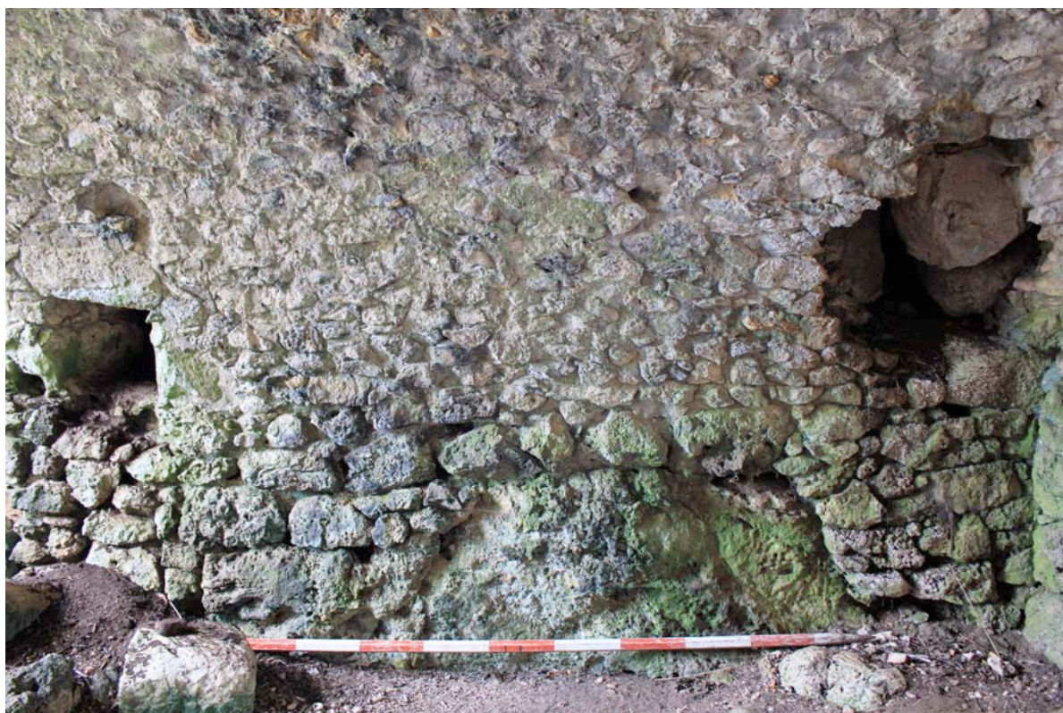
Fig. 103: Construcción del criptopórtico sobre la roca
