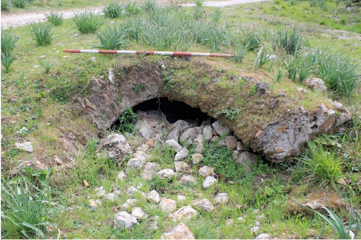
Fig. 64: Bóveda de estructura en la insula 21
