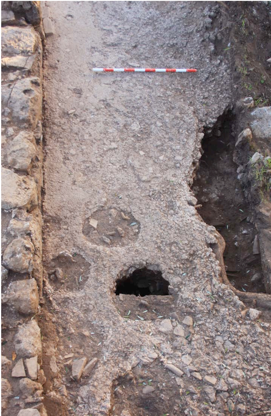
Fig. 123: Agujeros del pavimento del patio
