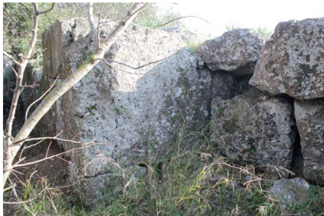
Fig. 19: Muralla entre las torres 9 y 10
