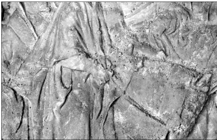
8. Mismo detalle, antes y después de la intervención
